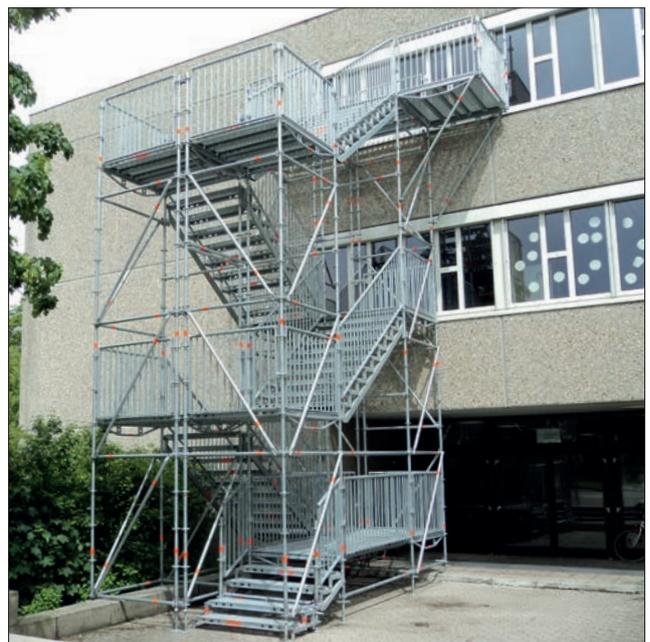
**Anpassung der Ein- und Austrittshöhen** im Treppenfuß- oder -kopfbereich durch Ausgleichstreppen mit verschiedenen Steighöhen.
