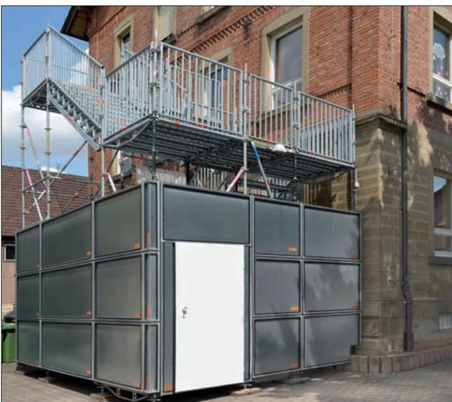
Um **Unbefugte am Betreten des Treppenturms zu hindern**, kann der untere Austrittsbereich der Treppe mit dem Layher Protect-System eingehaust werden. Die ideale Ergänzung bildet das Protect-Türelement, welches nur ein Öffnen von innen erlaubt.
