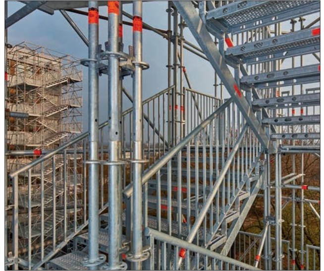
Auch **große Bauhöhen** von über 20 Metern sind problemlos **möglich** – die Traglast lässt sich durch eine Aufdopplung der Stiele weiter steigern.
