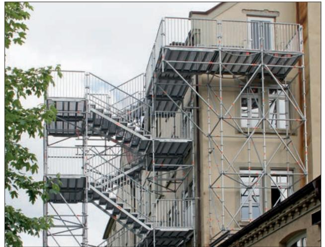
Um Fluchttreppenanlagen **von verschiedenen Stellen des Gebäudes aus erreichbar** zu machen, können auskragende Gebäudeumläufe in der obersten Lage komplett durch Serienteile des Allround-Systems realisiert werden.
