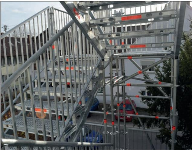
Die erforderlichen **Durchgangshöhen** können bei Bedarf durch den Einsatz verschiedener Diagonalen in Verbindung mit der klemmbaren Lochscheibe aus dem AllroundGerüst-Baukasten **erhöht werden**.
