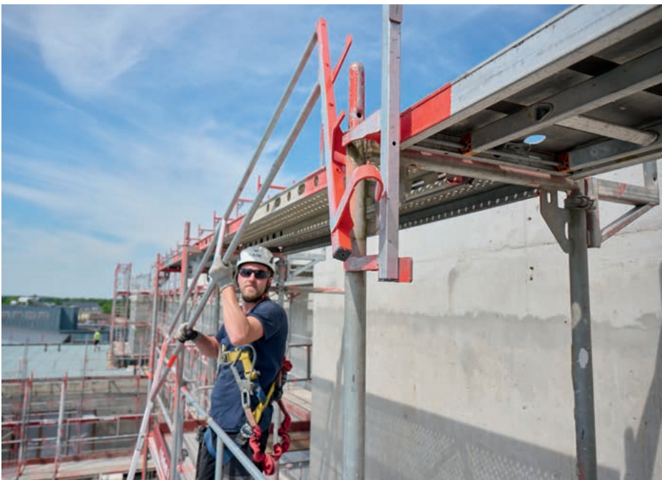
Das I-Geländer lässt sich ganz einfach aus gesicherter Lage einhängen.
