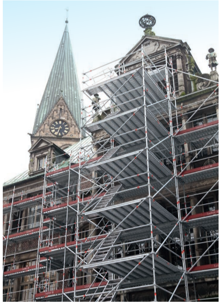
Ein großzügig dimensionierter Treppenturm schafft den sicheren Zugang für die Restauratoren.
