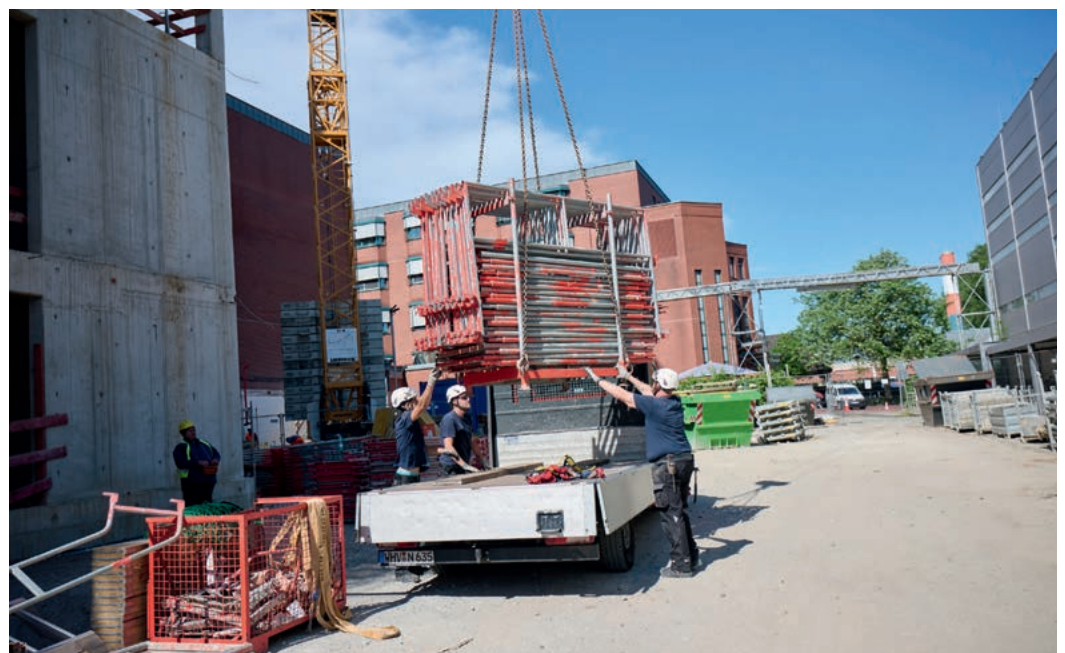
Auf der Baustelle zeigen auch die praxiserprobten Layher Logistiklösungen ihre Effizienz.
