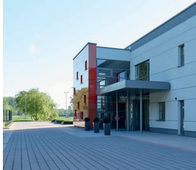
Die Nietiedt Zentrale in Wilhelmshaven ist seit Jahren wichtiger Praxispartner von Layher weit über Norddeutschland hinaus.
