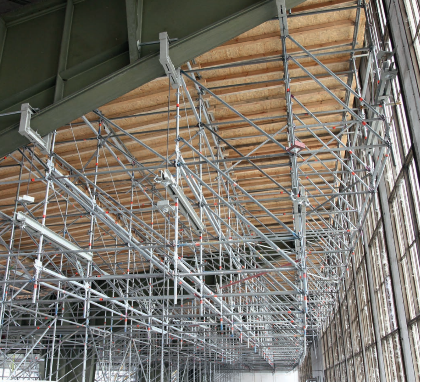
Das Arbeitsgerüst musste aufwändig an den Dachbindern abgehängt werden, da die Gebäudeteile darunter nicht belastbar waren.
