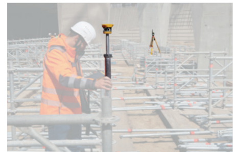
Verlässliches Anlegen durch 3D-Modelldaten
