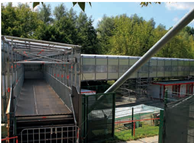
Temporäre Fußgänger-Ersatzbrücke aus Allround Brückenträger mit Überdachung und Protect-Einhausung
