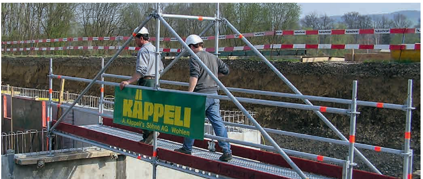
Grabenbrücke aus 2 AllroundGerüst-Feldern
