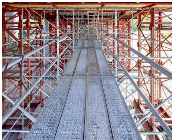
Arbeitsgerüst in Hohlkästen der Brückenkonstruktion
