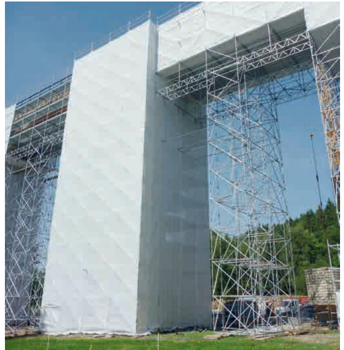
Mit Planen verkleideter Steinbogen-Viadukt
