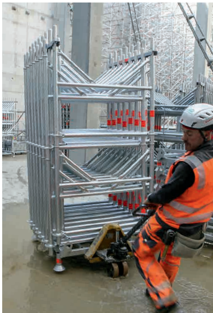
Befüllte TG 60-Rahmenpaletten können einfach per Hubwagen auf der Baustelle bewegt werden.
