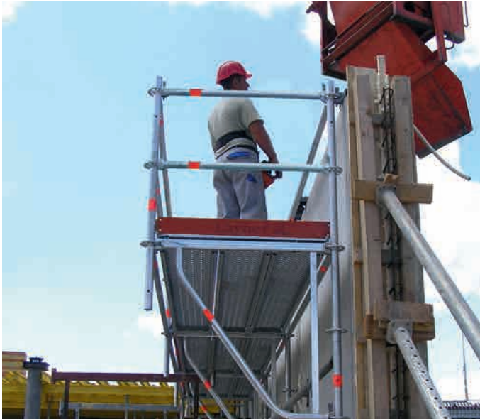
1,09 m breites Betoniergerüst mit Hohlwandkonsoladapter
