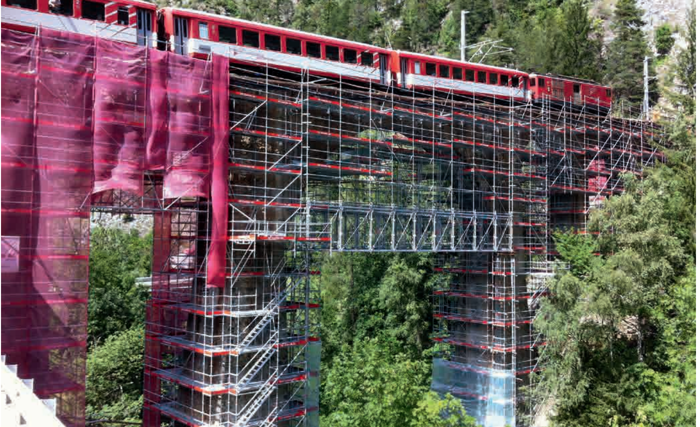
Stehendes Arbeitsgerüst an Steinbogenbrücke mit Allround Brückenträger zur Abfangung
