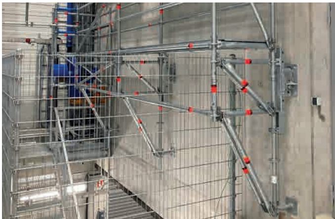
Hängendes Arbeitsgerüst über einem Treppenlauf mit Allround Wandkonsole
