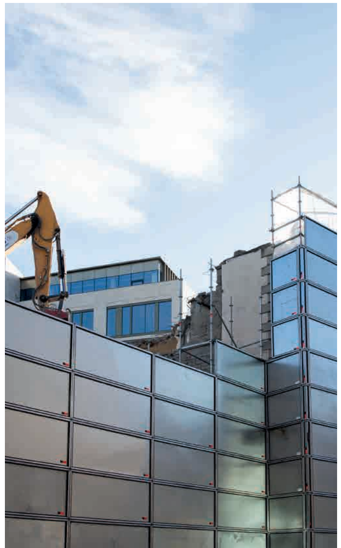
Lärm- und Staubschutzwand bei Abbrucharbeiten
