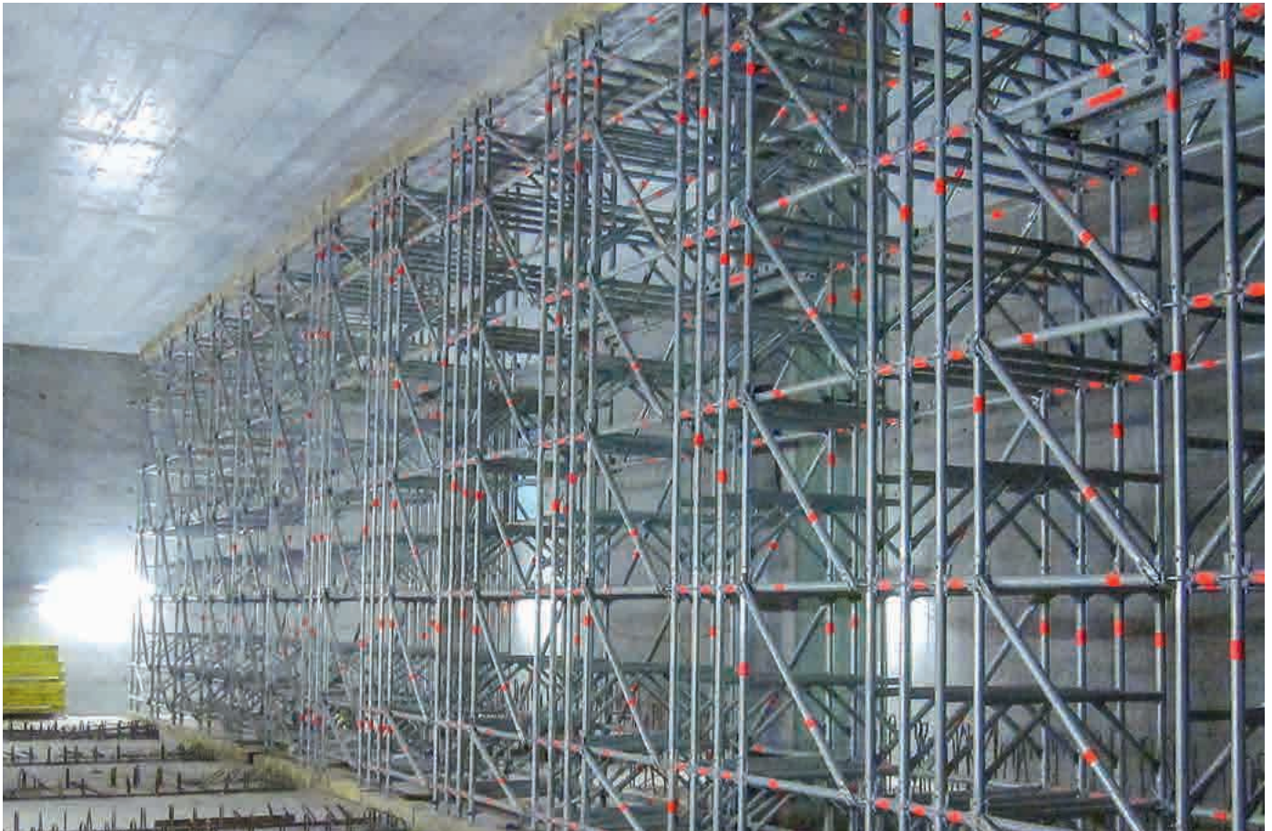
Rahmenbündellung zur Abtragung großer Lasten von 22 Tonnen pro Laufmeter
