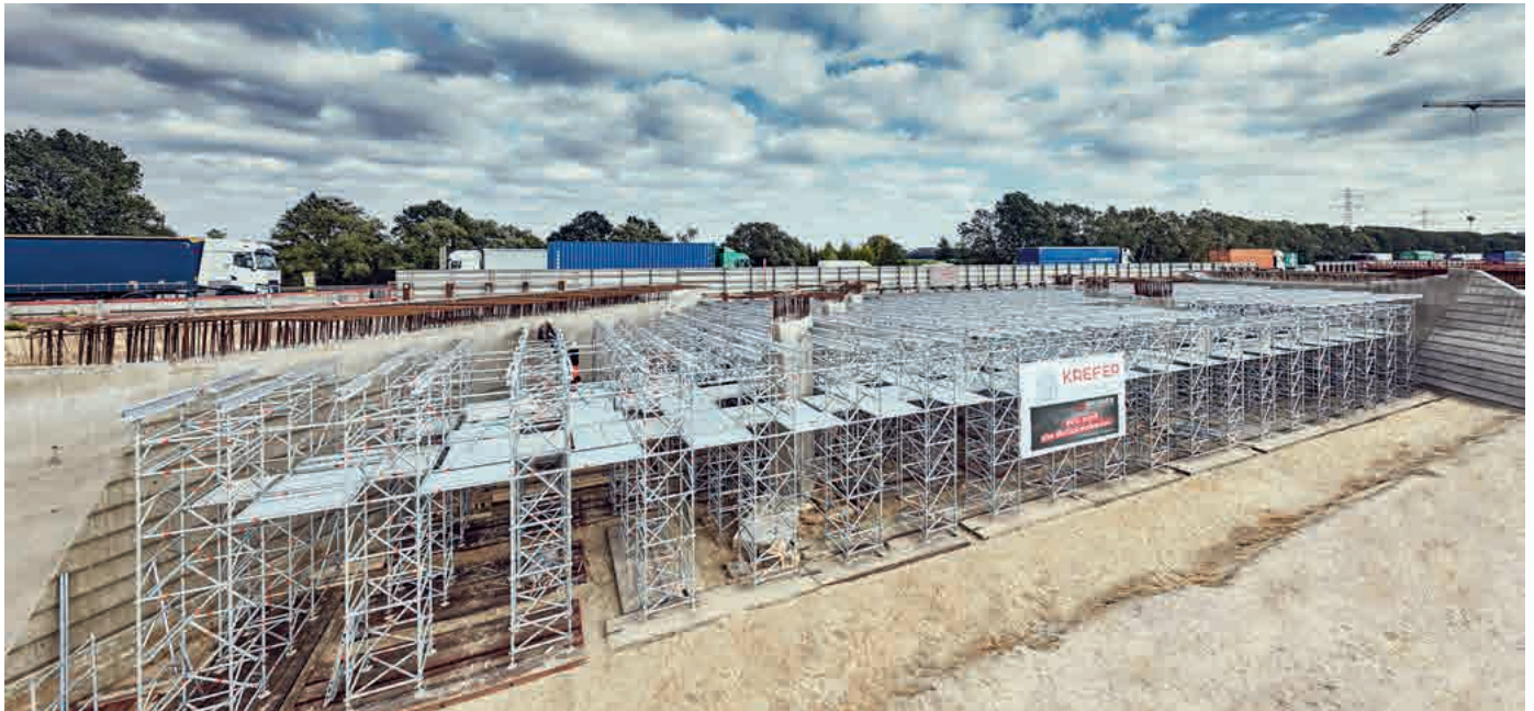
Großflächiges Traggerüst zum Bau eines Autobahnkreuzes mit TwixBeam als System-Jochträger
