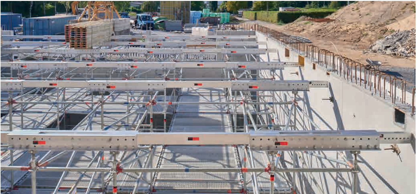
Aluminium-Träger TwixBeam als System-Jochträger – der Einschubträger dient als Verbindung zwischen den TwixBeam-Trägern und zur Anpassung an den Randbereich der Deckenschalung
