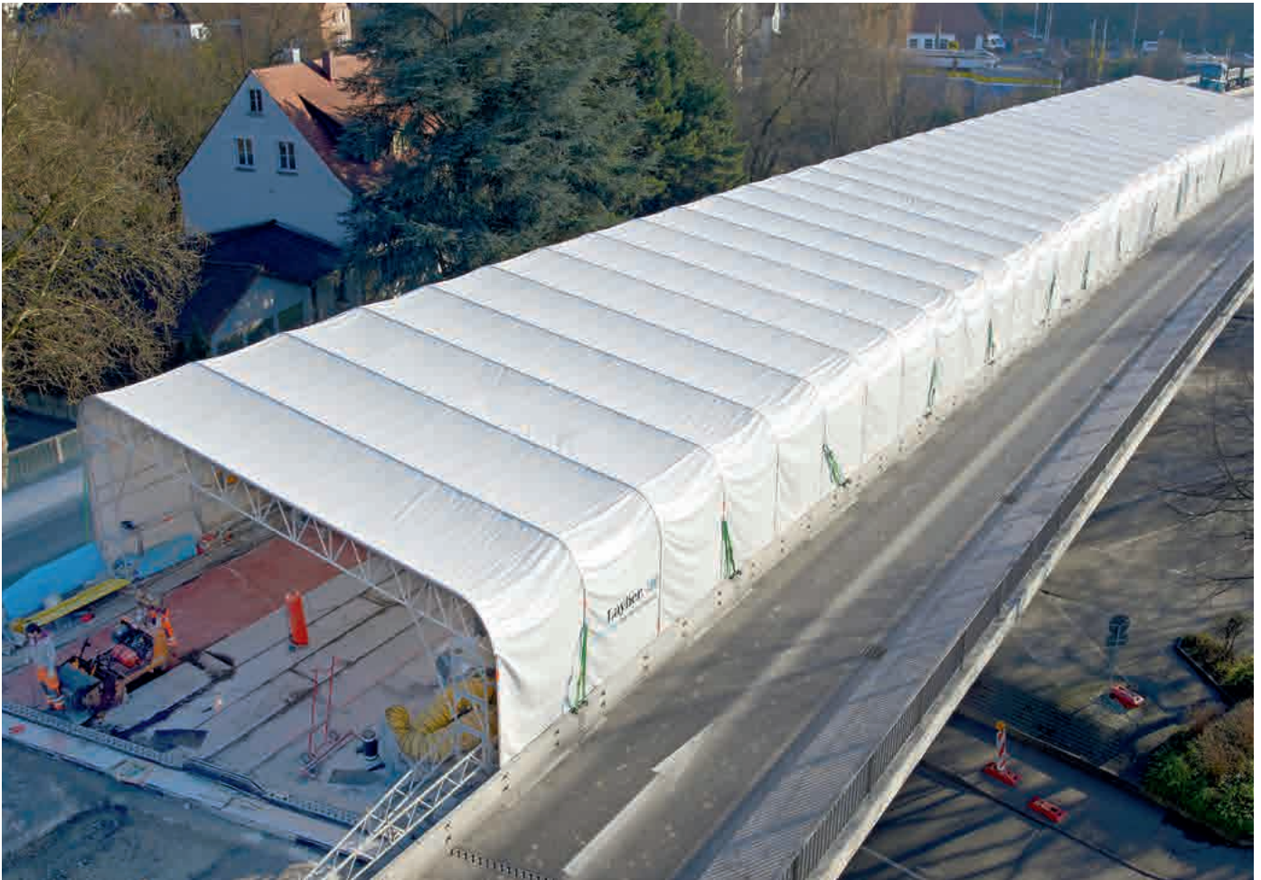
Kederdach XL auf Blitz Gerüst für Winterbaumaßnahme im Straßenbau
