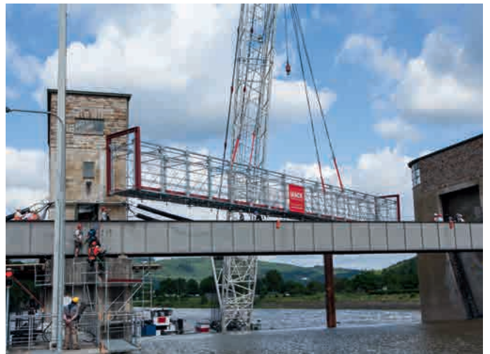
Einheben der temporären Ersatzbrücke per Schwimmkran
