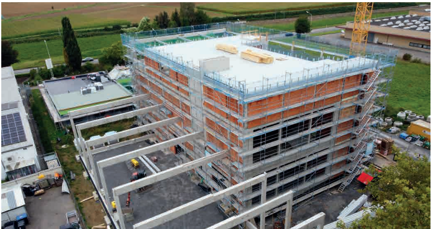
0,73 m breites Blitz Arbeitsgerüst mit vorgestellter Podesttreppe
