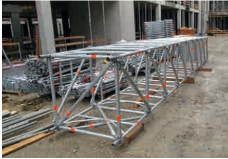
Liegende Vormontage des Traggerüstturms TG 60
