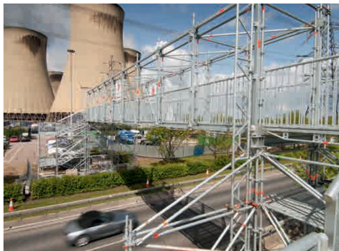
Temporäre Fußgänger-Ersatzbrücke aus Allround Brückenträger mit Treppenturm 750 zur Baustellenlogistik
