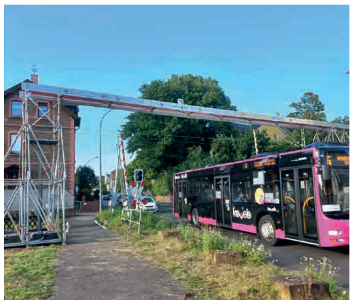
Kabelbrücke aus Aluminium-Träger FlexBeam auf Allround Stützgerüsten
