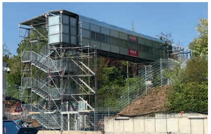
Temporäre Fußgängerbrücke mit Protect-Einhausung und Kassettendach
