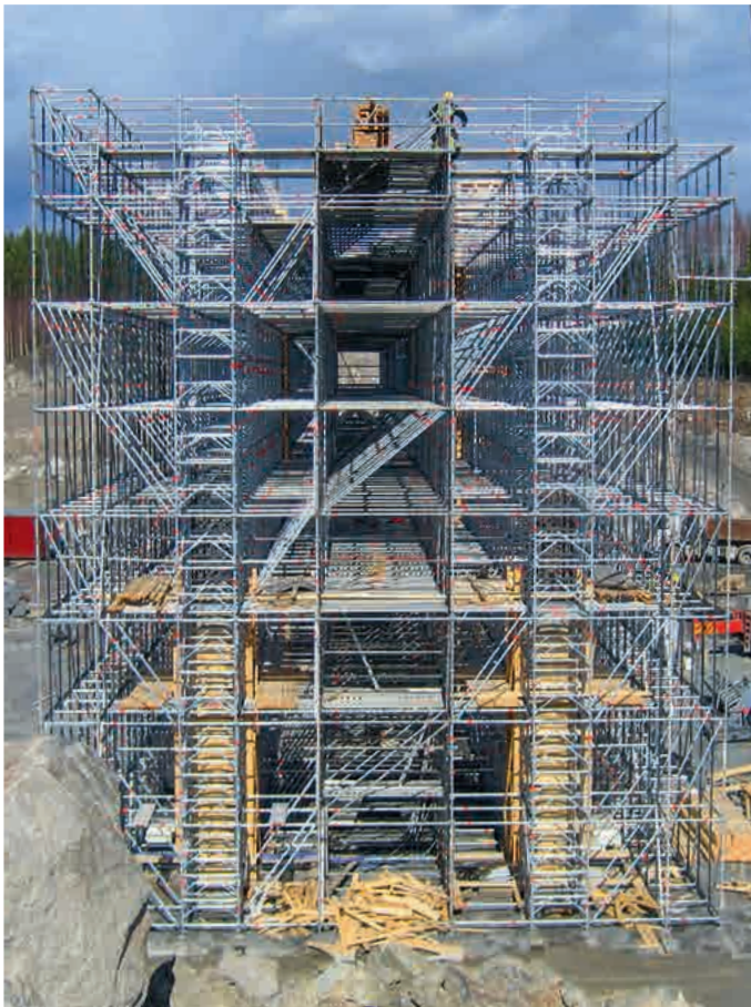
Traggerüst aus Allround Traggerüst TG 60 und AllroundGerüst beim Bau einer Straßenbrücke
