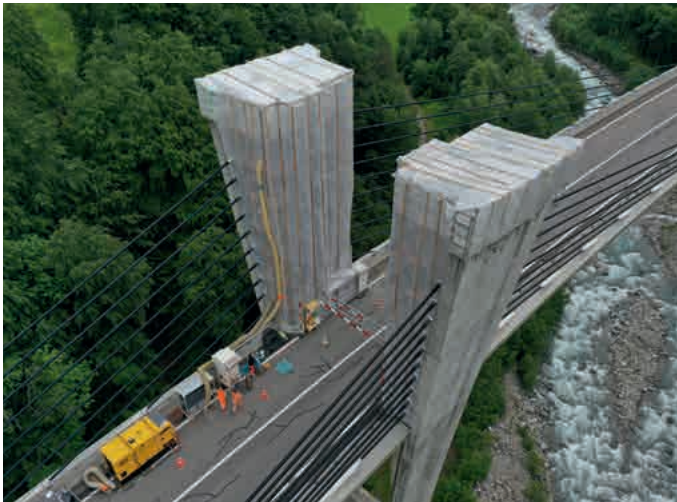
Mit Planen verkleideter Schrägseilbrückenpylon
