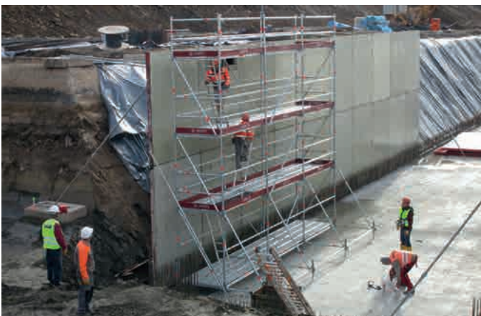
1,40 m breites Bewehrungsgerüst mit Abstützung
