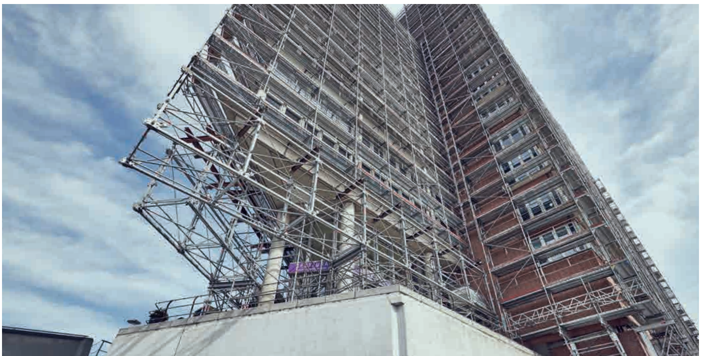
Auskragende Abfangung eines Fassadengerüsts
