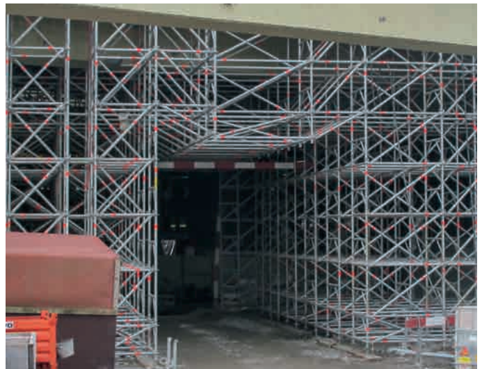
Durchfahrtsloch durch den Einsatz von Allround-Serienmaterial
