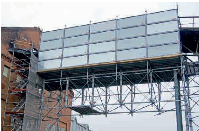
Mit Protect-System verkleidetes Arbeitsgerüst an einer Rohrbrücke zur Brand-sanierung
