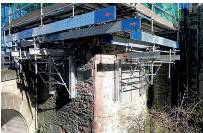
Hängendes Arbeitsgerüst an einem Brückenpfeiler einer Steinbogenbrücke
