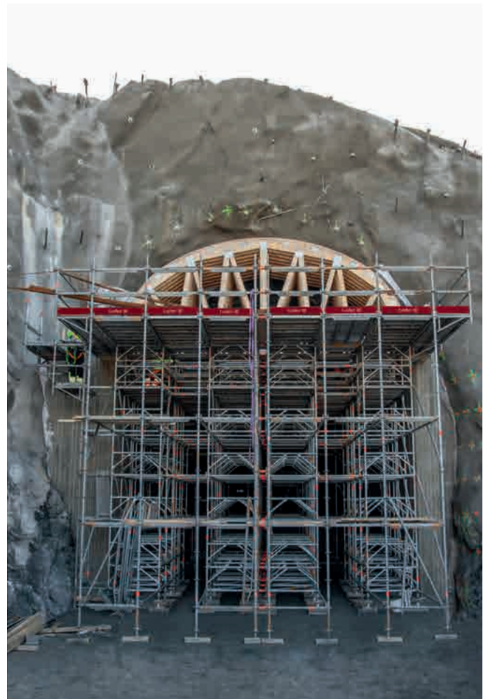
Traggerüst TG 60 für Tunnelbetonierarbeiten
