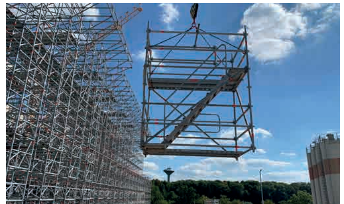
Kranversatz eines Treppenmoduls
