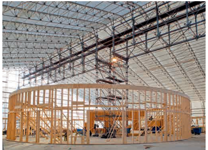
Kederdach XL für Winterbaumaßnahme bei Holzbauarbeiten
