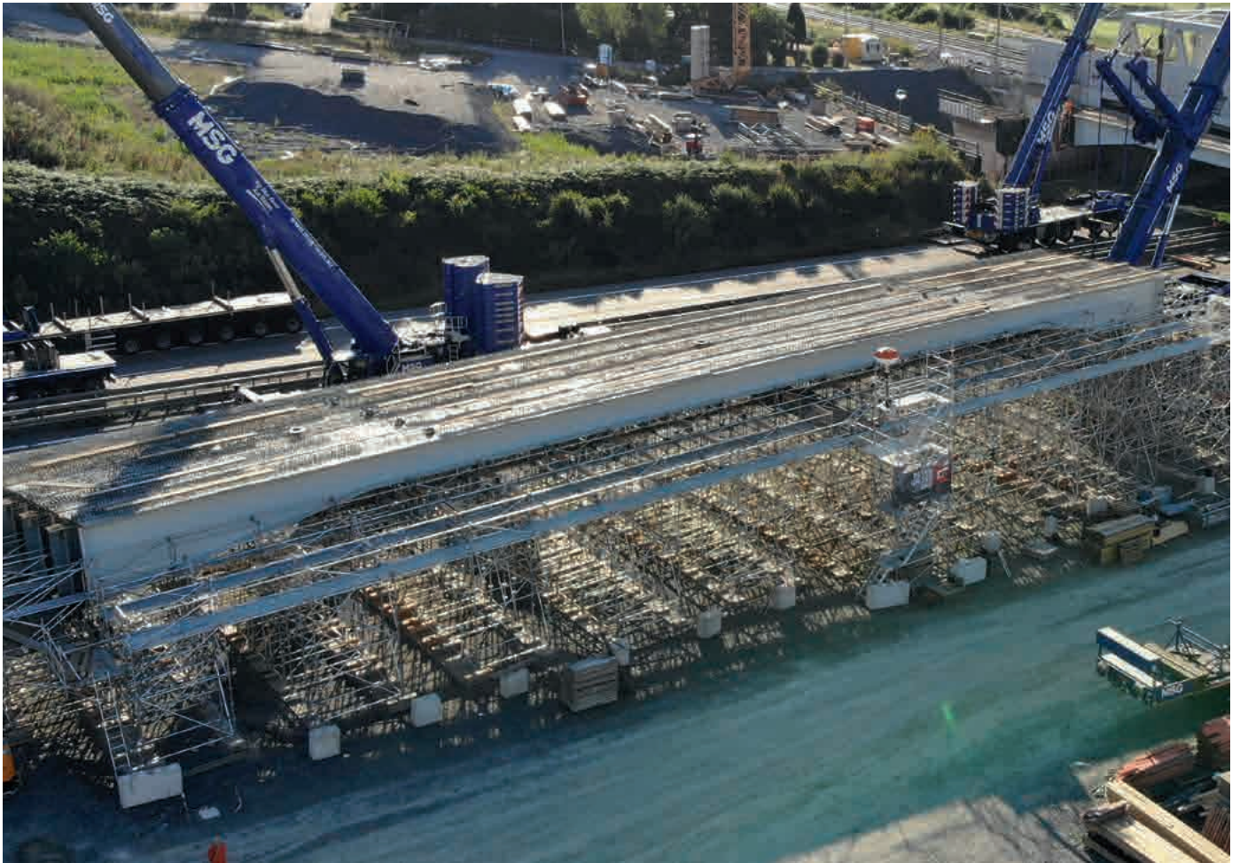
Traggerüst aus Allround-Serienteilen beim Neubau einer Autobahnbrücke
