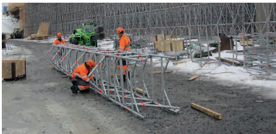
Liegende Montage eines Traggerüstturms TG 60
