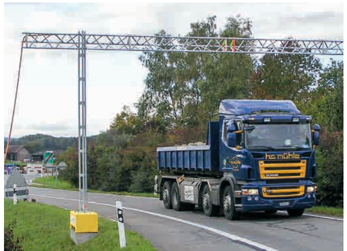
Kabelbrücke aus Gitterträgern und Dreiecksstützen inklusive Betonballast
