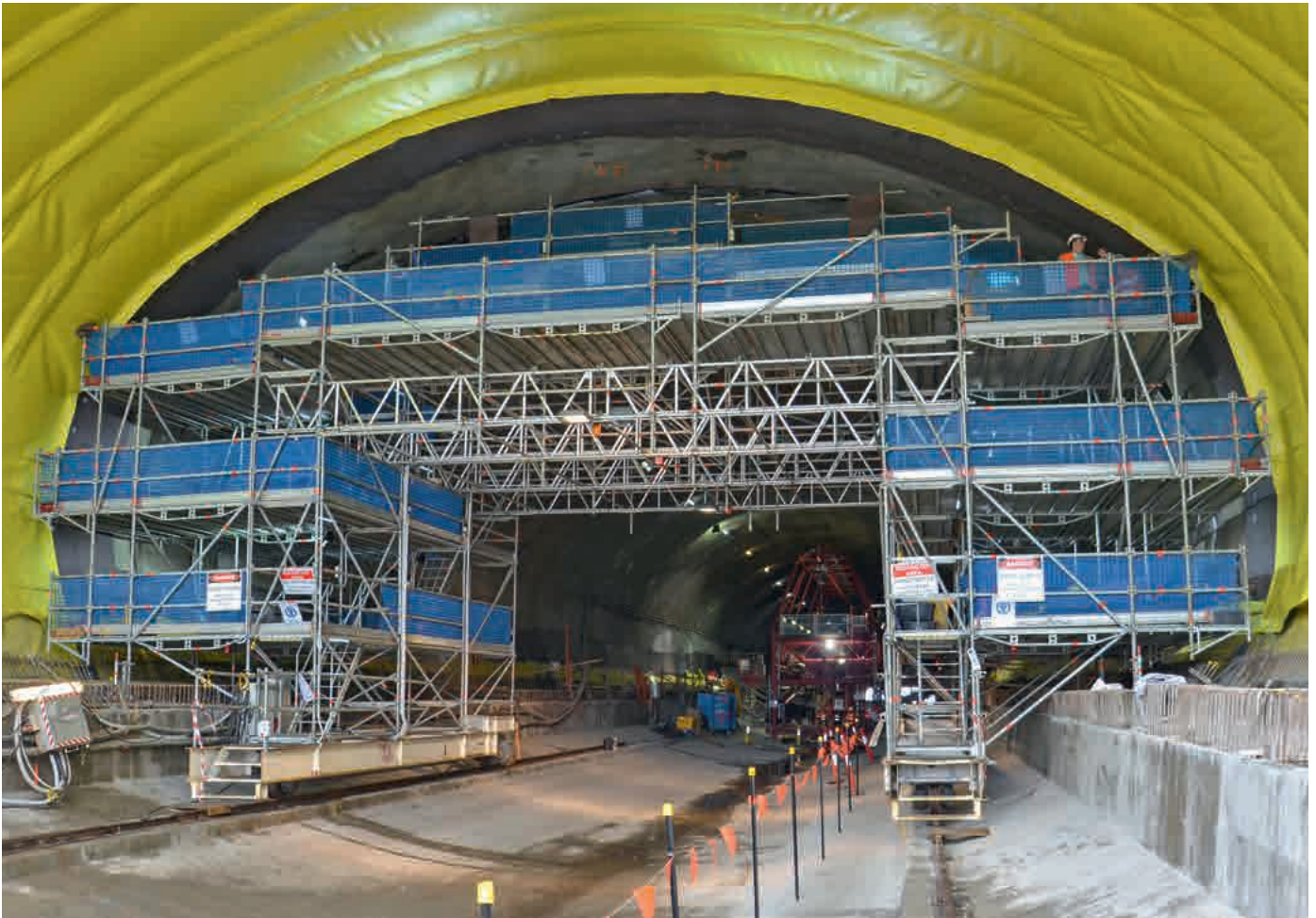
Auf Schienen fahrbares Tunnelfahrgerüst
