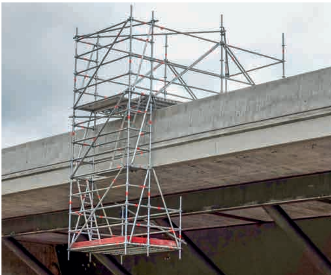
Fahrbares Brückenkappengerüst
