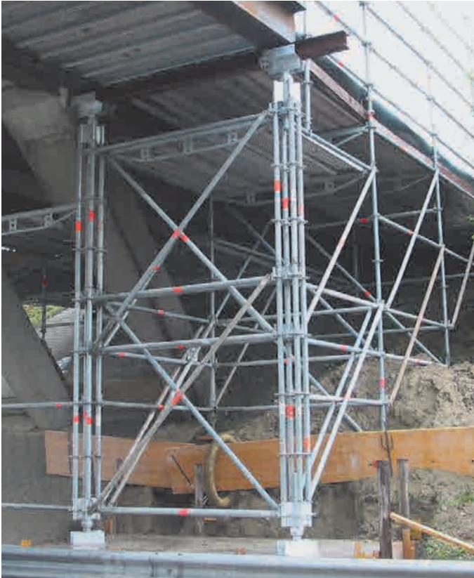
Schwerlaststütze beim Brückenbau
