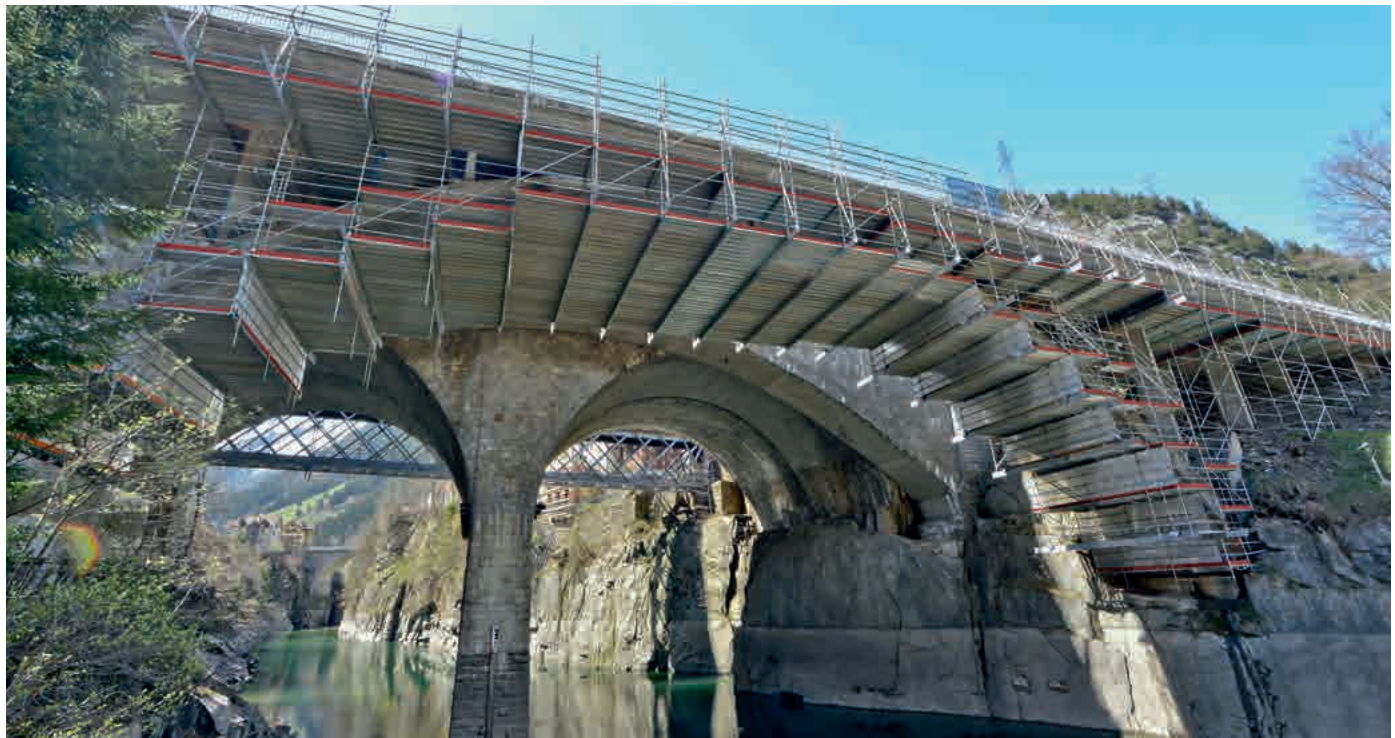
Brückenuntersichtsgerüst mit 2 Ebenen aus Aluminum FlexBeam an Viadukt
