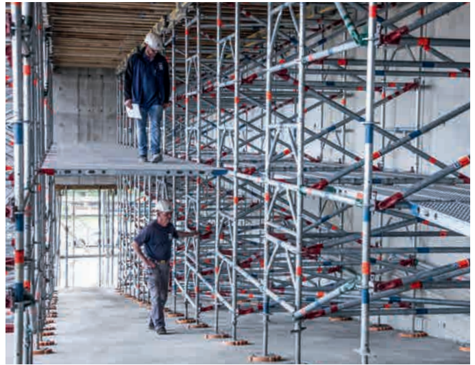
Integrierte Belagebenen im Traggerüst und mit Ausgleichsplatten an Untergrundneigung angepasstes Traggerüst
