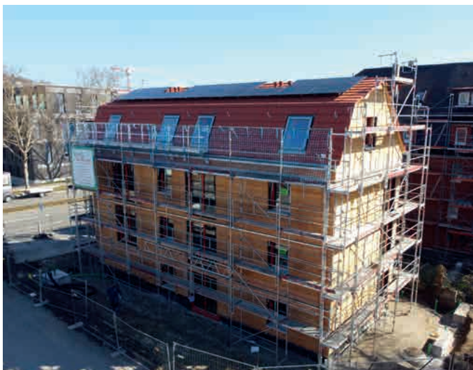
Blitz Fassadengerüst mit I-Geländer und integrierter Dachfangeanlage
