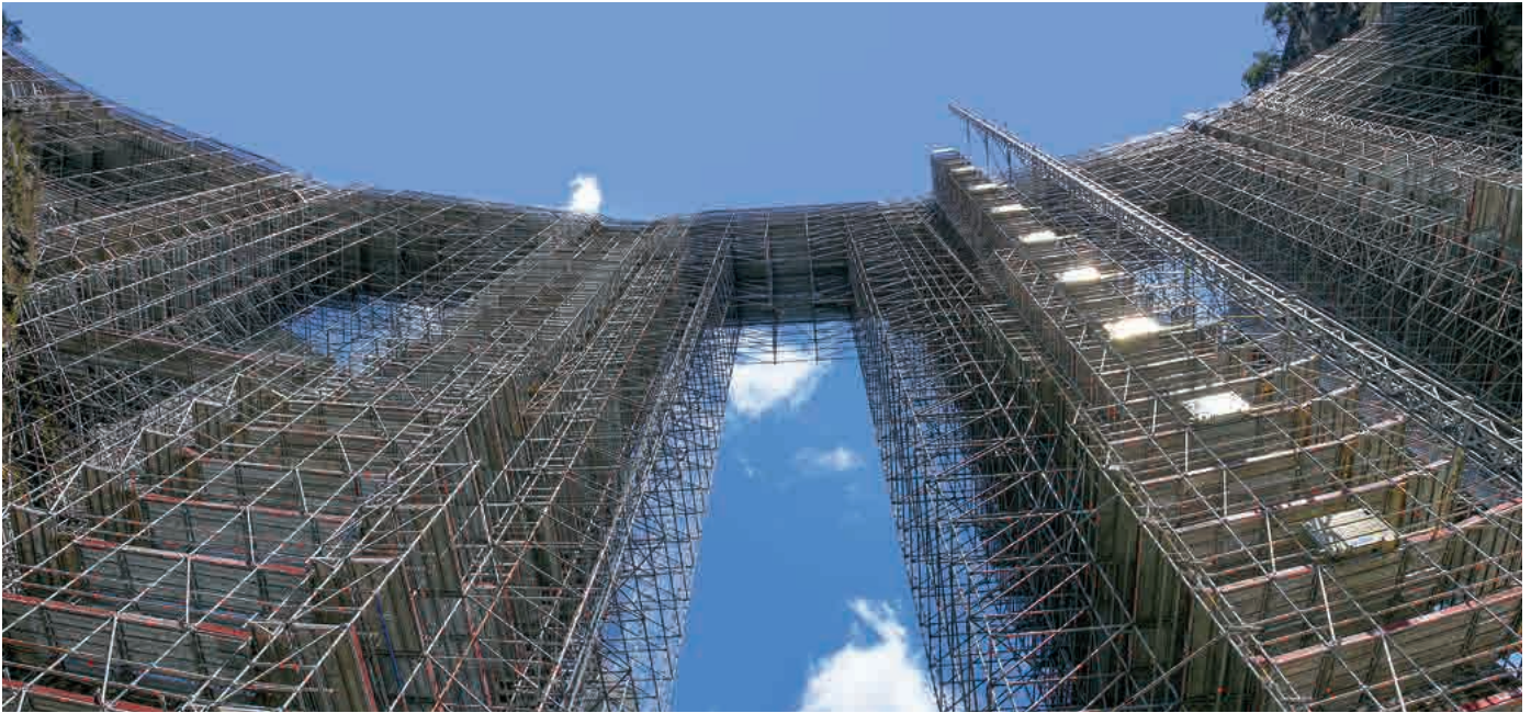
Stehendes Arbeitsgerüst an Steinbogenbrücke
