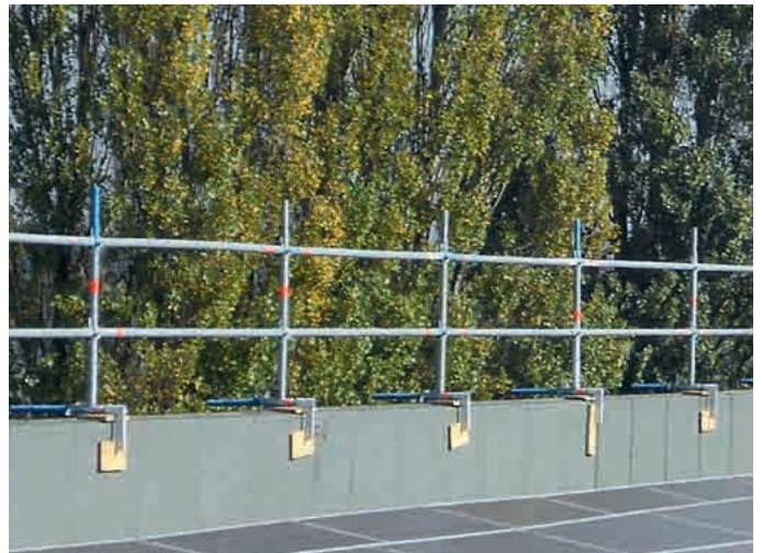
Einsatz einer Brüstungsklammer an einem Flachdach mit hoher Attika
