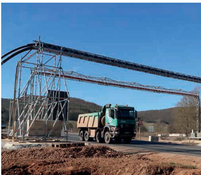
Kabelbrücke aus Gitterträgern und Dreiecksstützen inklusive Betonballast
