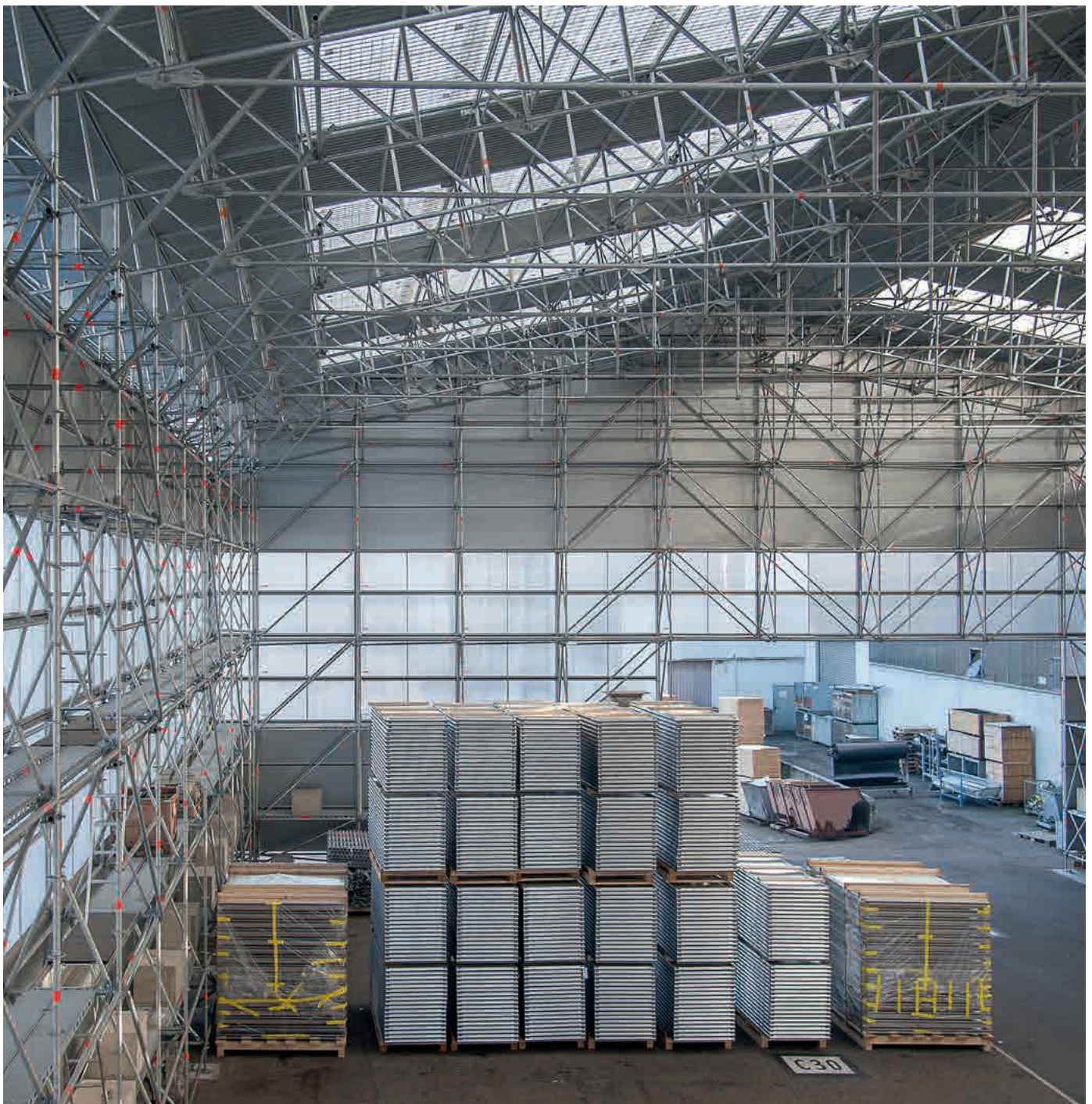
Temporäre Halle aus AllroundGerüst, Protect-System und Kassettendach
