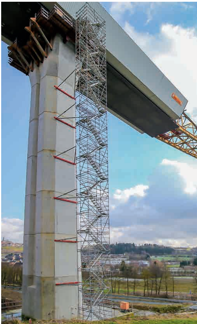
Pfeilerzugang mit Allround Modultreppenturm
