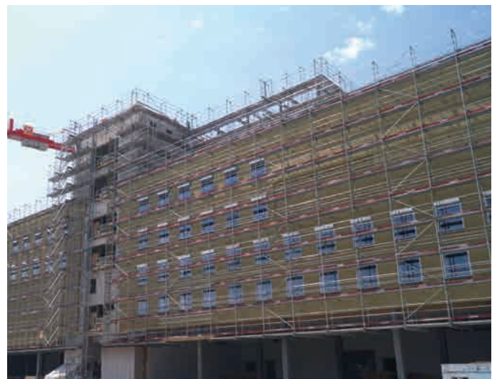
Fassadenarbeitsgerüst aus Layher Blitz Gerüst auf auskragendem Trägersystem aufgelagert zum Erhalt der Durchfahrt
