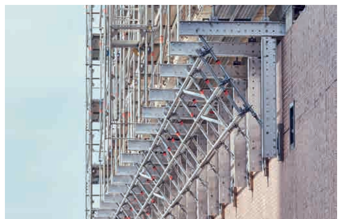
Hängendes Arbeitsgerüst auf TwixBeam-Konsolen
