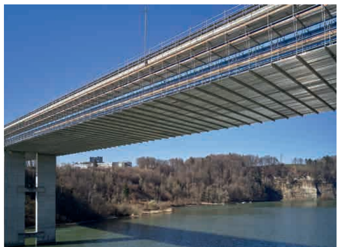
Ca. 7000 m 2 großes Brückenuntersichtsgerüst mit FlexBeam an Stahlverbundbrücke
