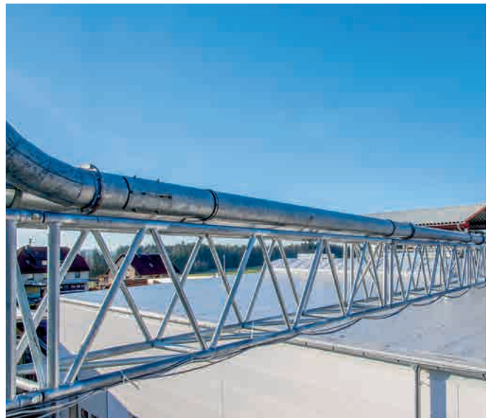
Rohrleitungsbrücke aus Stahl-Truss
