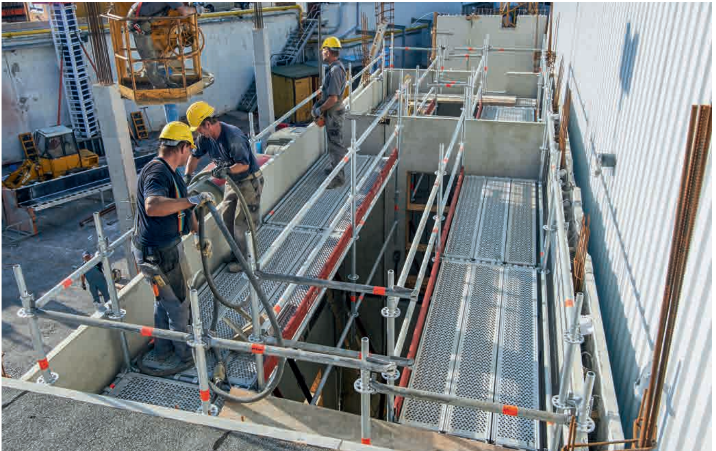
1,09 m breites Betoniergerüst mit Hohlwandkonsoladapter
