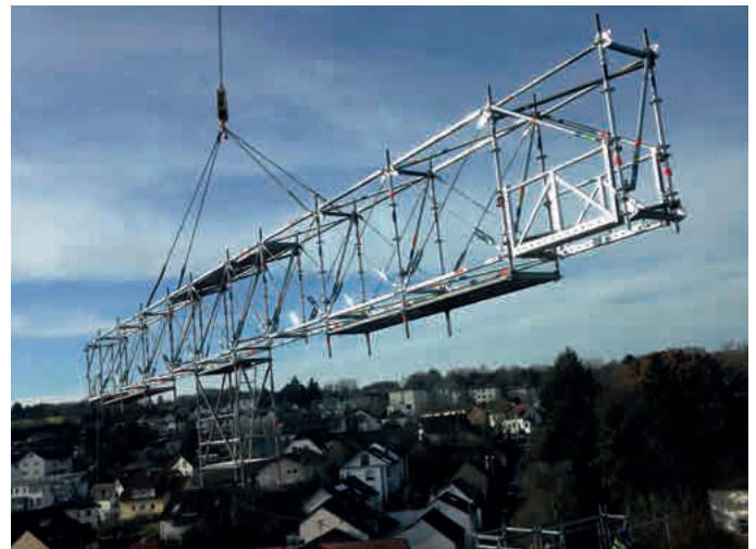
Verkranung einer Fachwerkträger-Überbrückung
