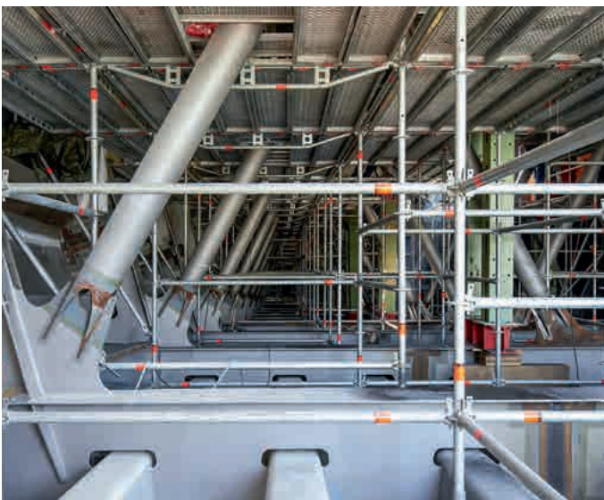
Arbeitsgerüst in Hohlkästen der Brückenkonstruktion
