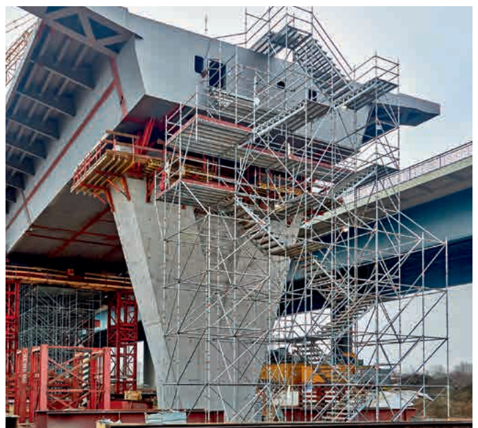
Bautreppenturm 200 als Zugang zur Fahrbahn, zu Hohlkästen und Brückenlager
