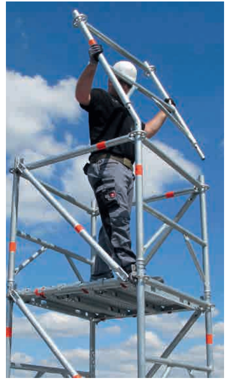
Sichere stehende Montage dank integriertem vorlaufenden Seitenschutz
