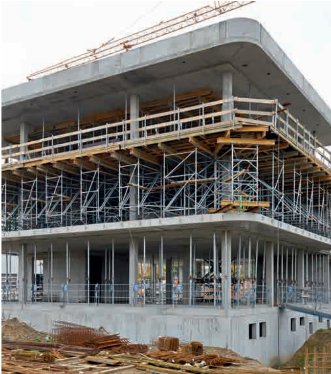
Eingespannt auskragende Allround Traggerüsttürme TG 60
