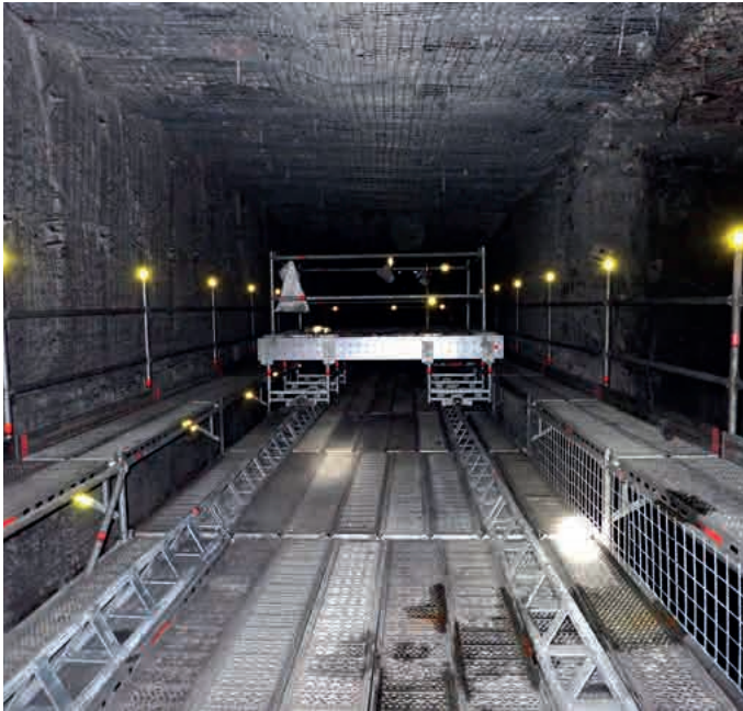
Fahrbares Tunnelbohrpodest, Australien
