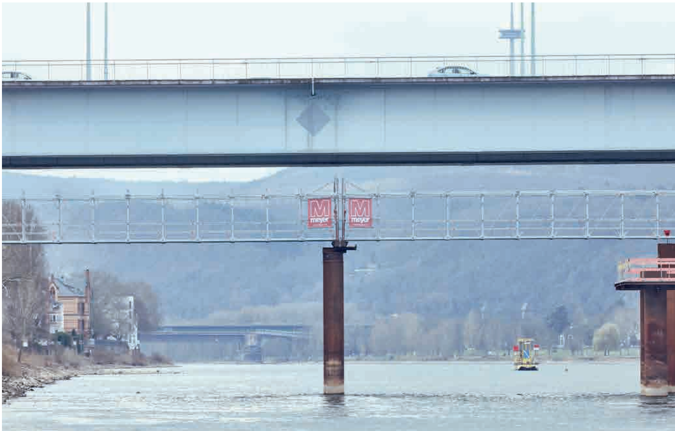
Temporäre Fußgänger-Ersatzbrücke aus Allround Brückenträger mit einer Spannweite von 2 x 31 Meter
