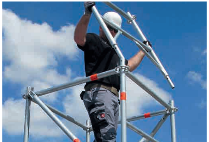
Systemintegrierter vorlaufender Seitenschutz bei der Montage von Traggerüsttürmen TG 60
