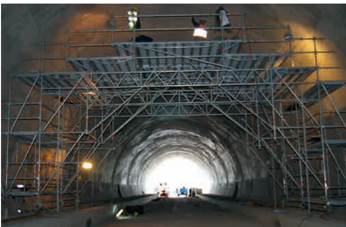
An die Tunnelgeometrie angepasstes, fahrbares Arbeitsgerüst mit Durchfahrtsöffnung
