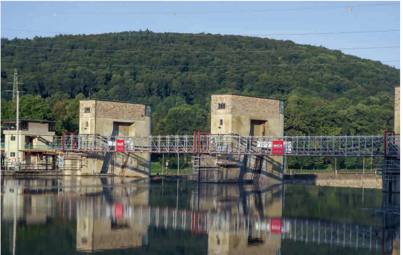
Temporäre Fußgänger-Ersatzbrücke mit 2 x 34 Metern Spannweite und einem Zwischenlager aus Allround Brückenträger
