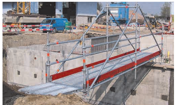
Grabenbrücke aus 2 AllroundGerüst-Feldern
