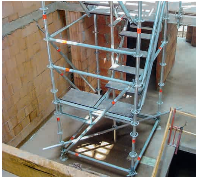
Rohbautreppenturm in einem Mehrfamilienhaus
