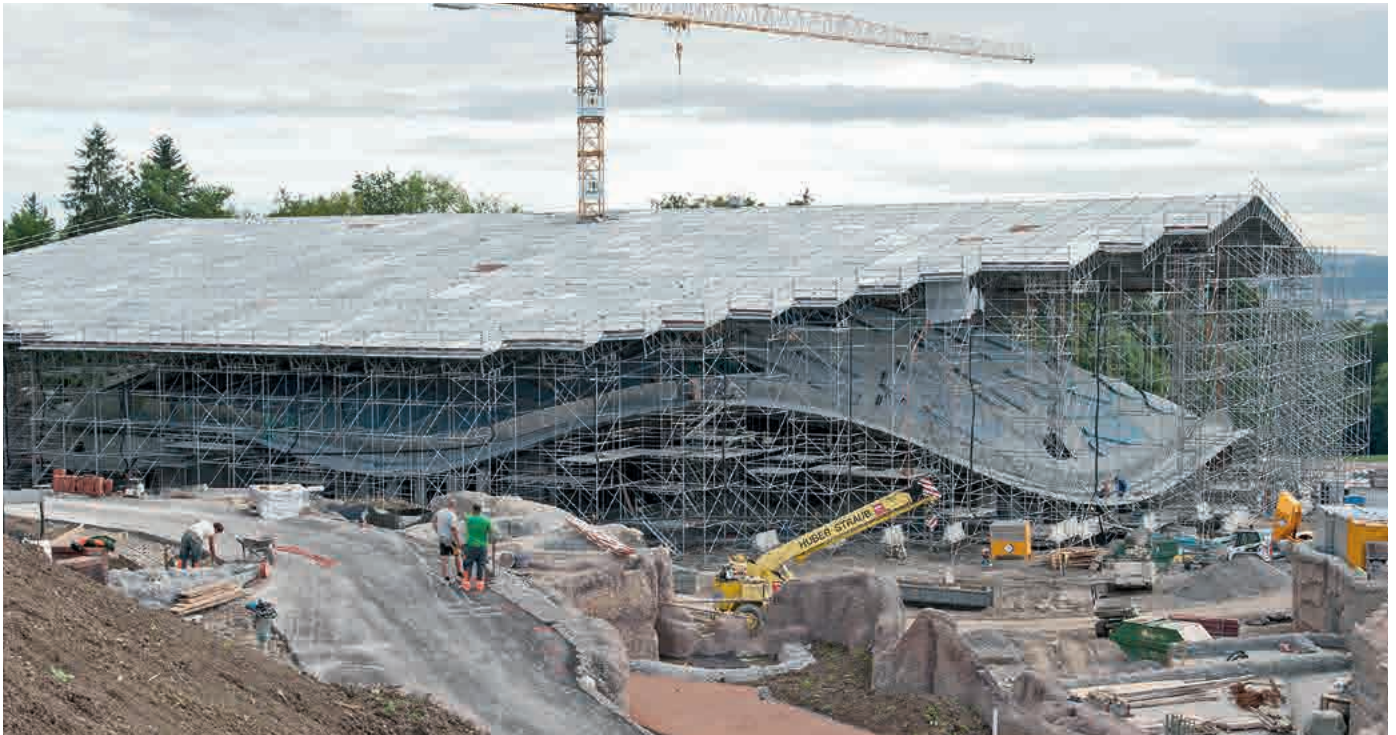
Wetterschutzdach beim Bau eines Tiergeheges
