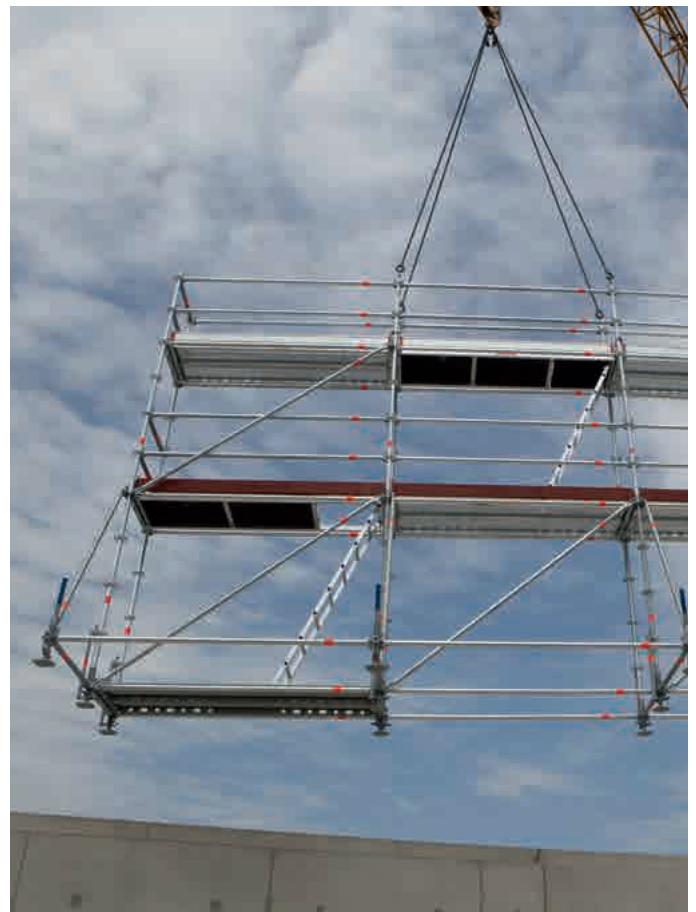
0,73 m breites Bewehrungsgerüst mit Abstützung beim Verkranen
