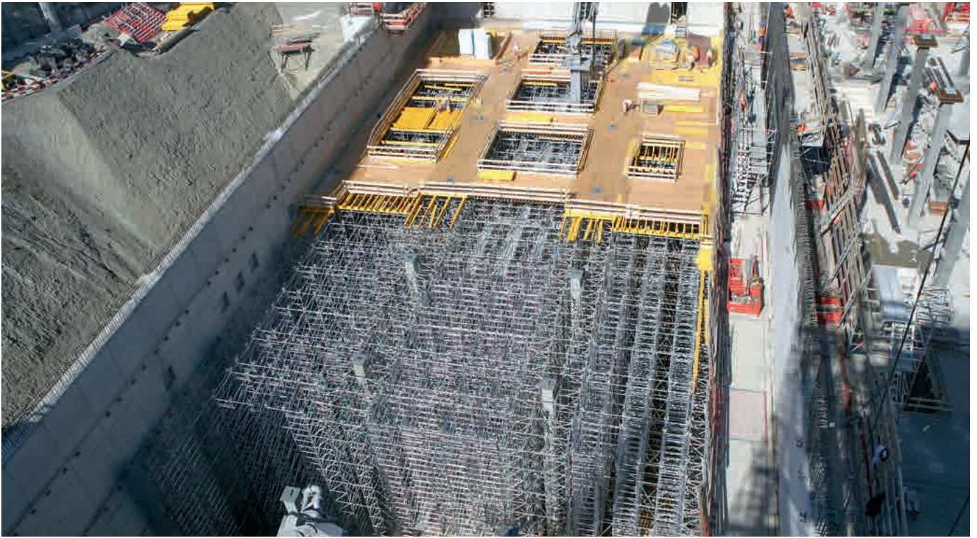
Die Herausforderung bei dieser Tragkonstruktion war eine kreuzweise vorgespannte Deckenkonstruktion zur Abfangung eines Hochregallagers.
