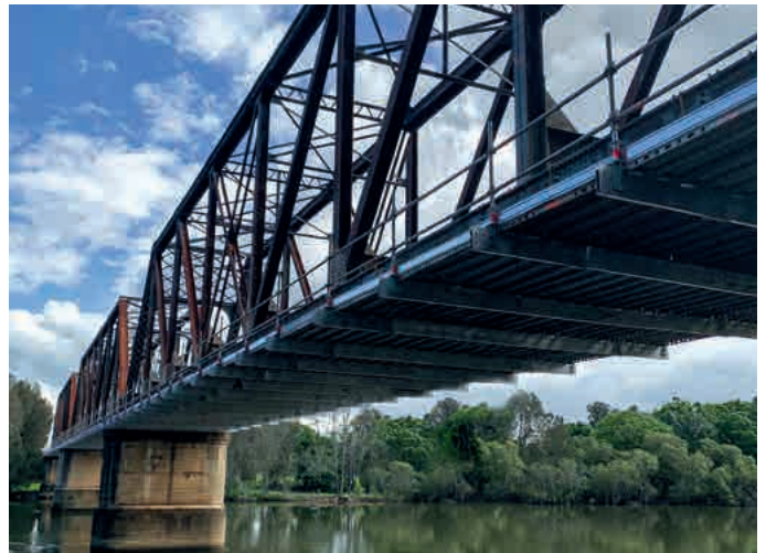
Hängendes Brückenuntersichtsgerüst mit Schutzwand auf Aluminum-Träger FlexBeam
