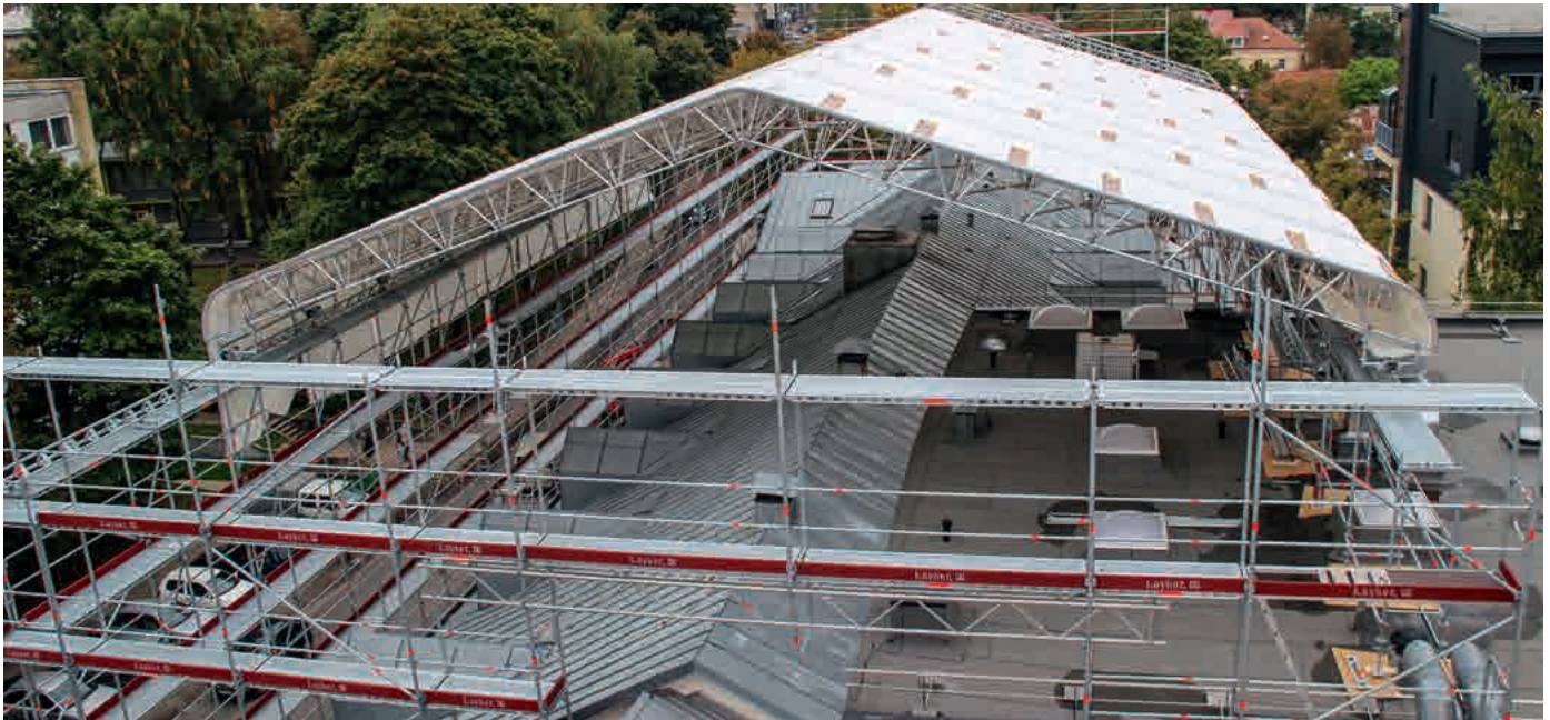
Fahrbares Kederdach XL auf Blitz Gerüst bei Dacharbeiten an einem Geschäftshaus
