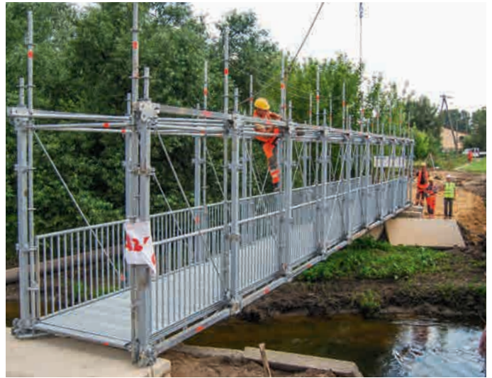
Behelfsbrücke mit ca. 18 Metern Spannweite
