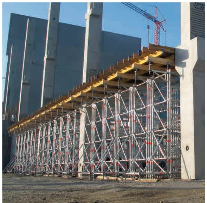
Durchfahrtsloch durch den Einsatz von Allround-Serienmaterial
