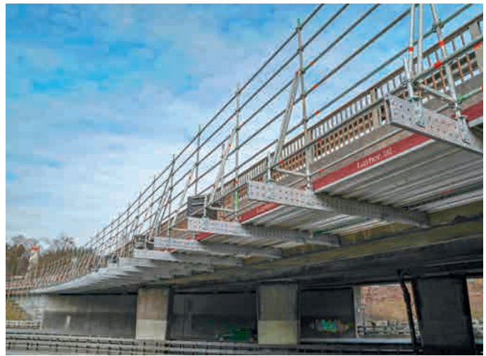
Brückenuntersichtsgerüst mit Schutzwand aus Aluminum FlexBeam
