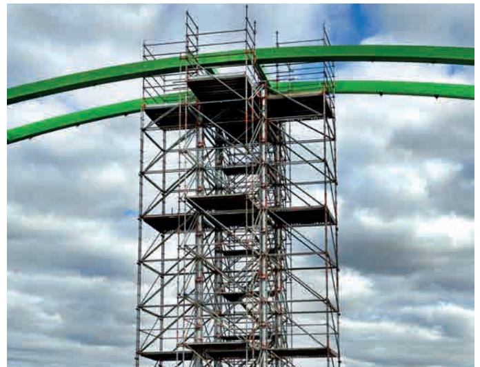
Abstützung des Parabelträgers einer Bogenbrücke
