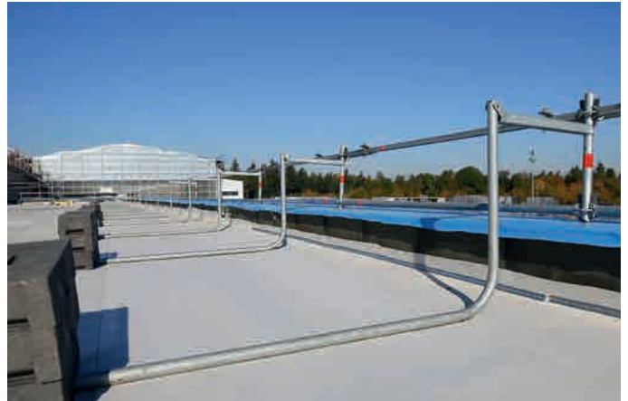
Flachdachseitenschutz auf Hallendach
