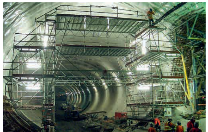
Auf Schienen fahrbares Tunnelfahrgerüst mit Arbeitsplattformen für sicheres Arbeiten
