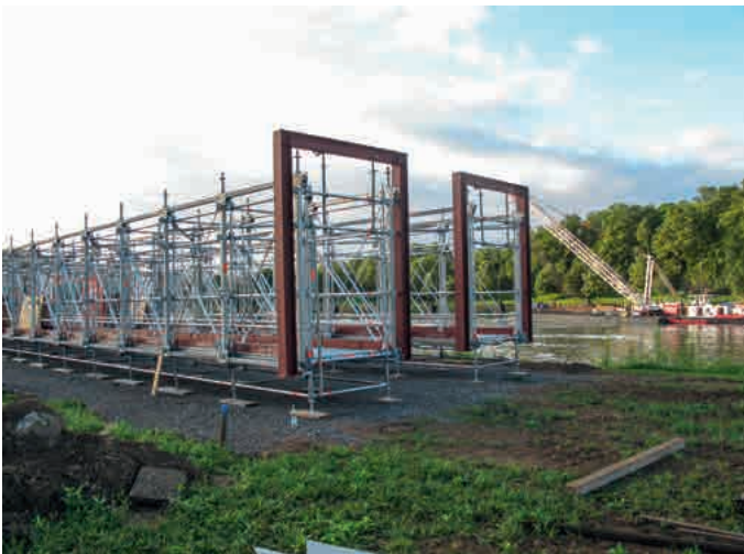
Vormontierte Brücken für späteres Einheben per Kran
