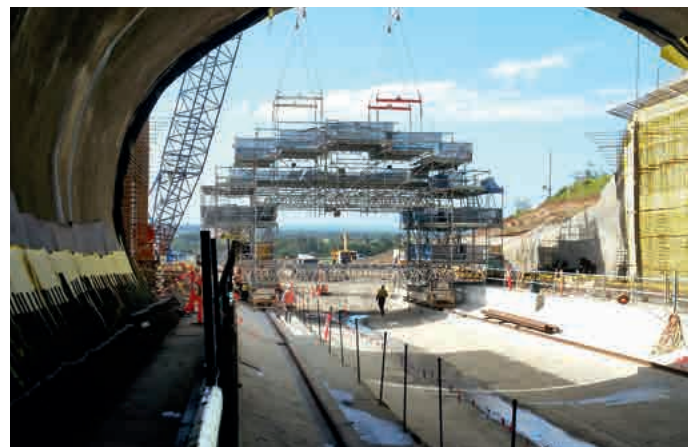
Voriges Einkranen eines vormontierten Tunnelfahrgerüsts
