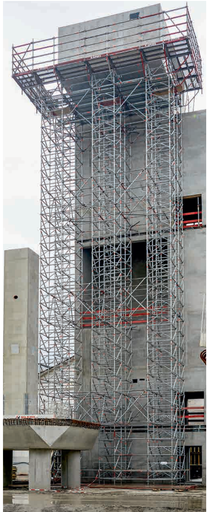
Hohe Stütztürme aus Allround Traggerüst TG 60 mit systemintegrierten Konsolgängen
