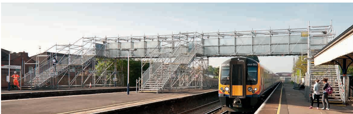
Temporäre Fußgänger-Ersatzbrücke aus Allround Brückenträger an Bahnsteig mit Treppentürmen 750 und innenliegender Protect-Einhausung
