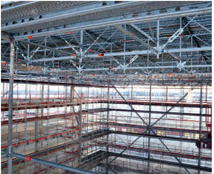
Freitragendes Deckengerüst in einem Einkaufszentrum
