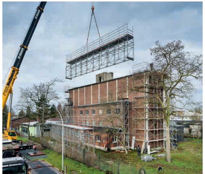
Überbrückung / Abfangung eines Arbeitsgerüsts über ein vorgelagertes, nicht tragfähiges Dach
