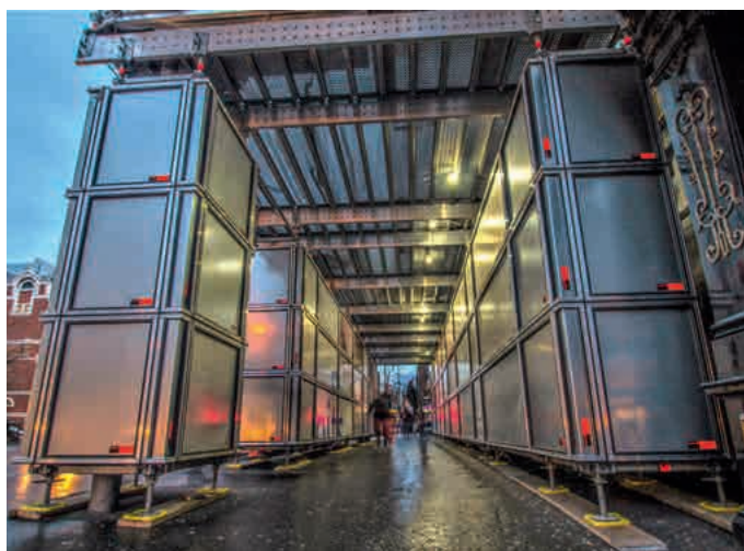
Arbeitsgerüst mit Fußgängertunnel mit FlexBeam und Protect-Einhausung
