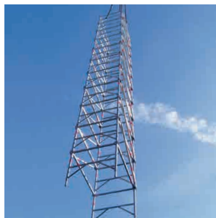
Kranversatz von am Boden liegend vormontierten Türmen
