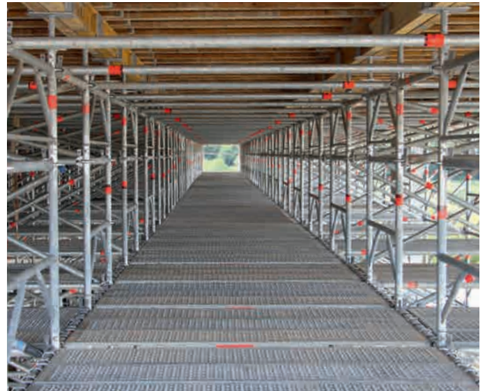
Integrierte Belagebenen im Traggerüst
