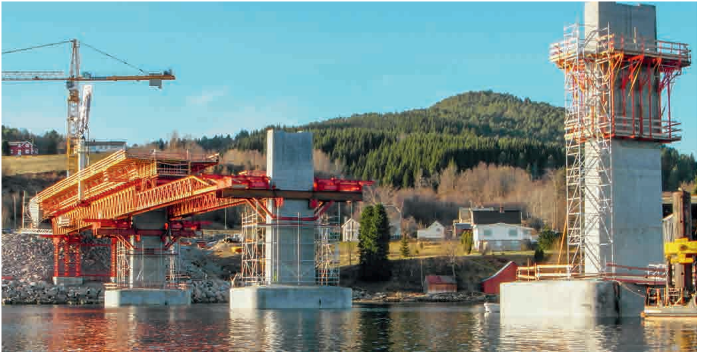
Pfeilereinrüstungen als Zugang zur Vorschubrüstung
