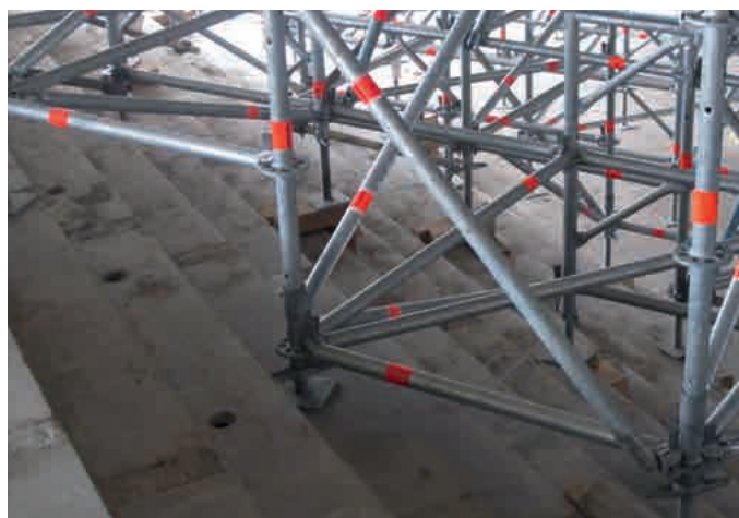
Anpassung des Traggerüsts an Treppenläufe mit Allround-Serienmaterial
