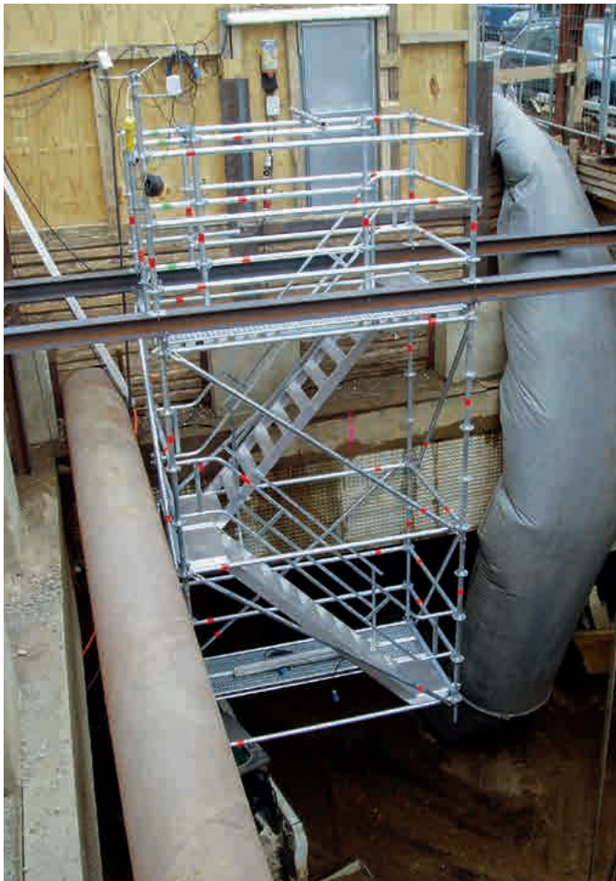
Gegenlaufender, hängender Podesttreppenturm
