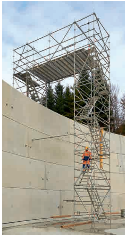
Gegenlaufender Modultreppenturm
