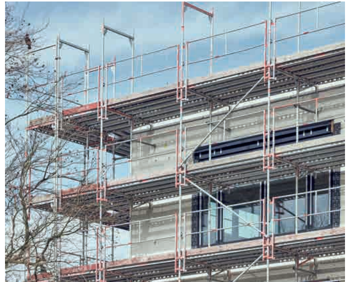
Blitz Fassadengerüst mit I-Geländer
