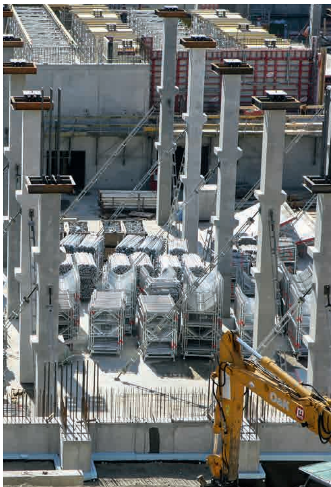
Befüllte Paletten werden vom LKW direkt per Kran an den Einsatzort gehoben.
