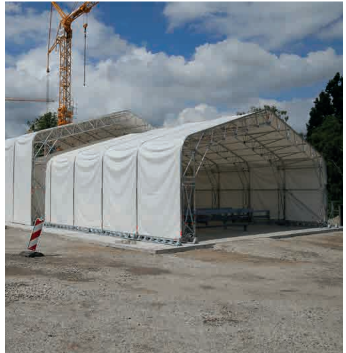
Ineinander verfahrbare Kederhallen zur Fertigung von Betonteilen
