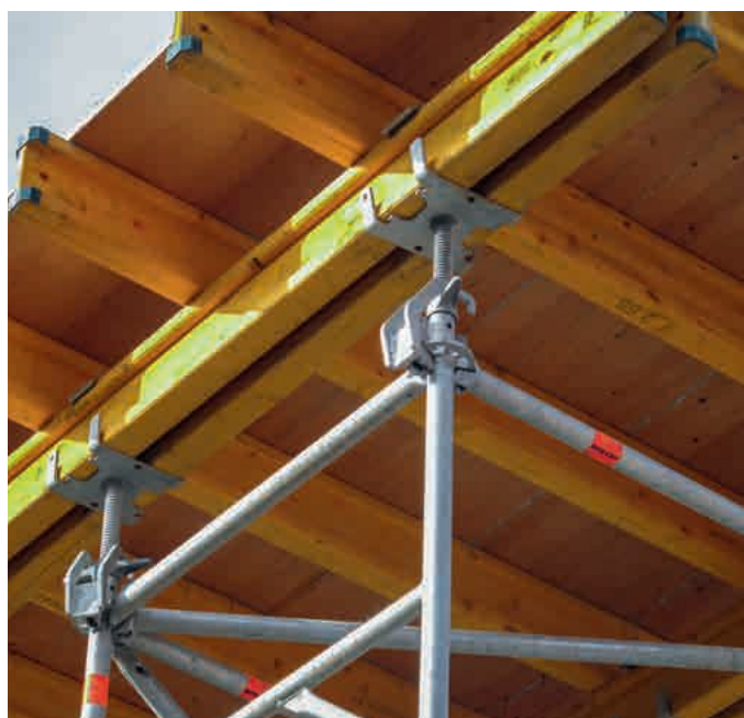
Traggerüst TG 60 als Deckentisch mit zugfester Verbindung der Schalung an die Traggerüsttürme
