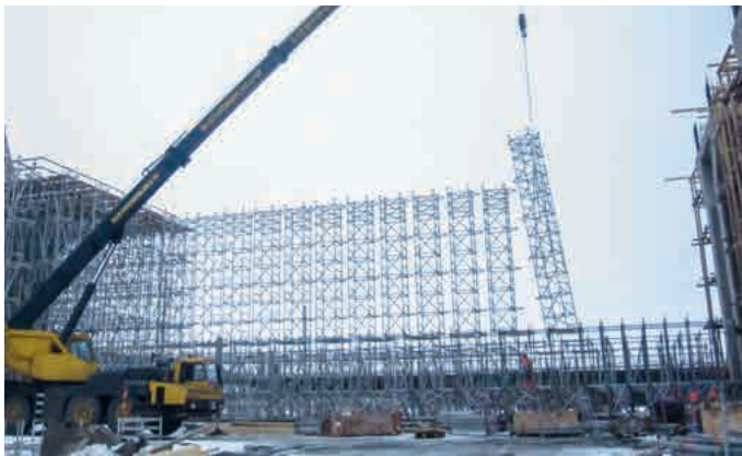
Kombination aus stehender und liegender Montage einzelner Traggerüsttürme TG 60 für Zeitgewinn im Aufbau
