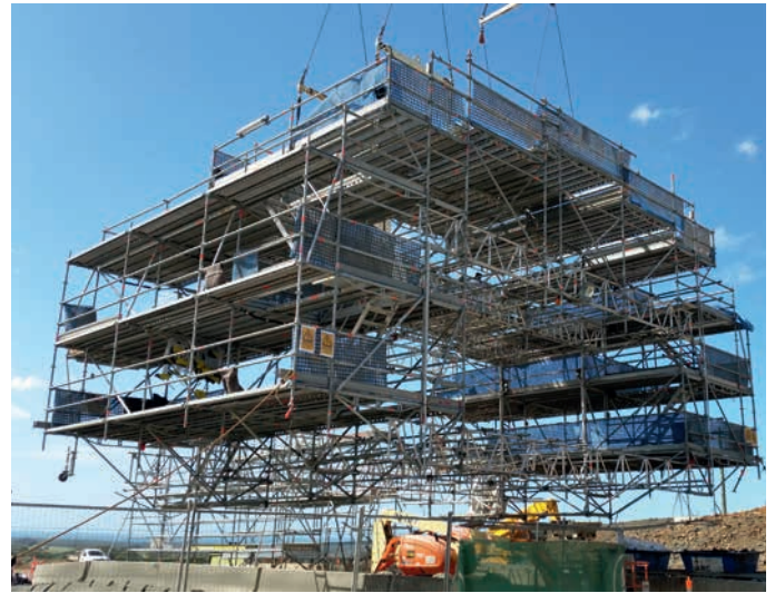
Auf Schienen fahrbares Arbeitsgerüst beim Einkranen
