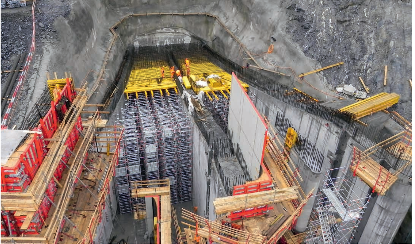
Traggerüst TG 60 an einem Ausflusstrichter eines Pumpspeicherwerks
