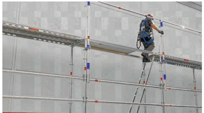
Sicheres Rüstern im Gerüstbau
