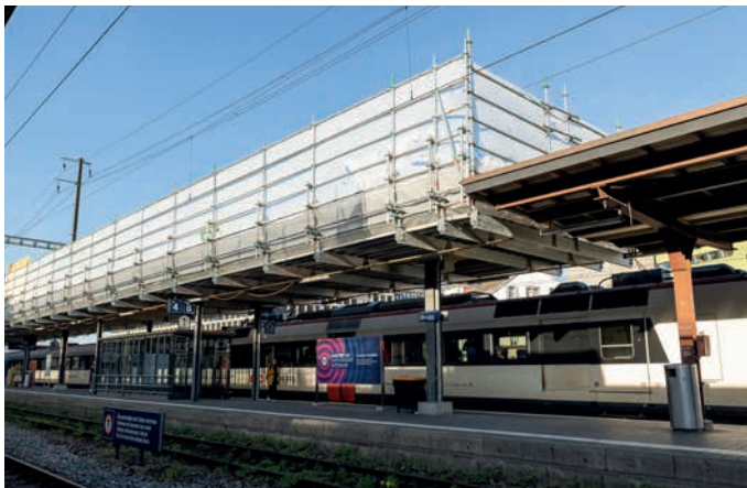
Ausragendes Hängegerüst mit Schutzwand an Bahnsteigüberdachung
