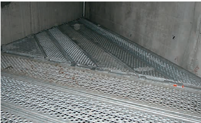
Dreiecks- und Trapezböden zur höhengleichen Ausdeckung von 45-Grad-Innen-ecken
