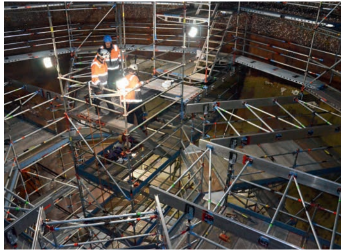
Überbrückung mit Aluminium-Träger FlexBeam bei einer Boiler-Innenrüstung
