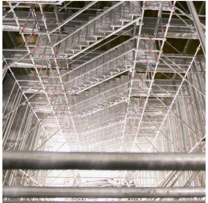
Treppenturm 200 bei Boiler-Innenrüstung
