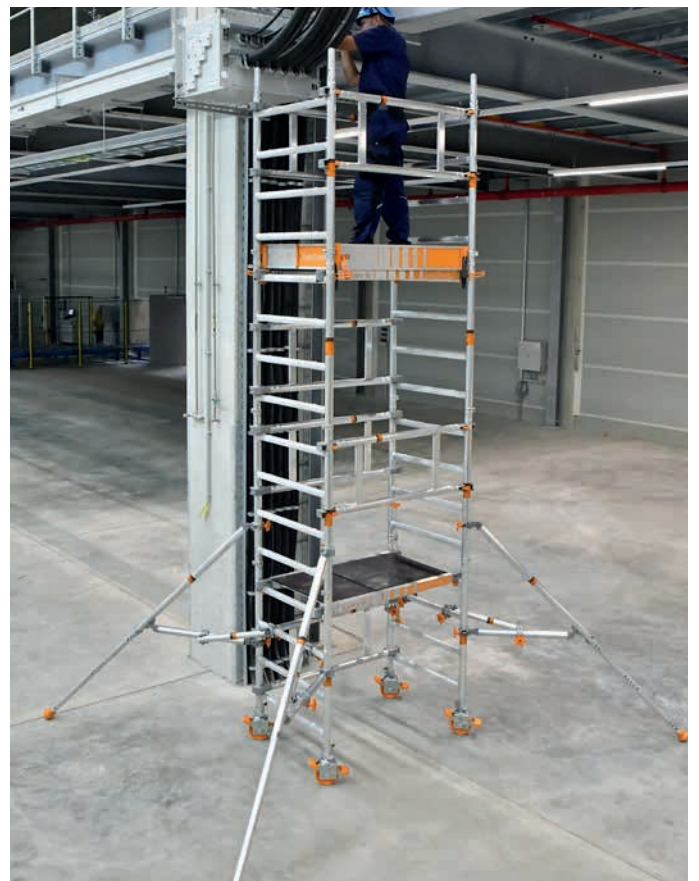
SoloTower – sichere 1-Personen-Montage durch die 3T-Methode
