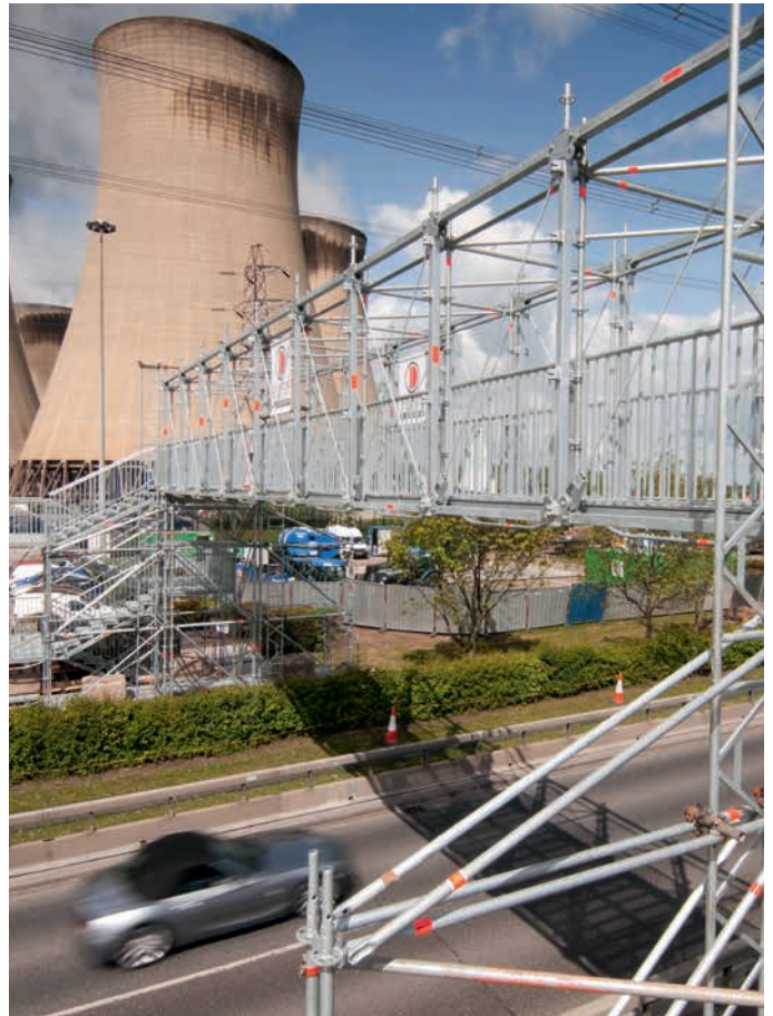
Temporäre Fußgängerbrücke als Personalzugang zu einem Kraftwerk
