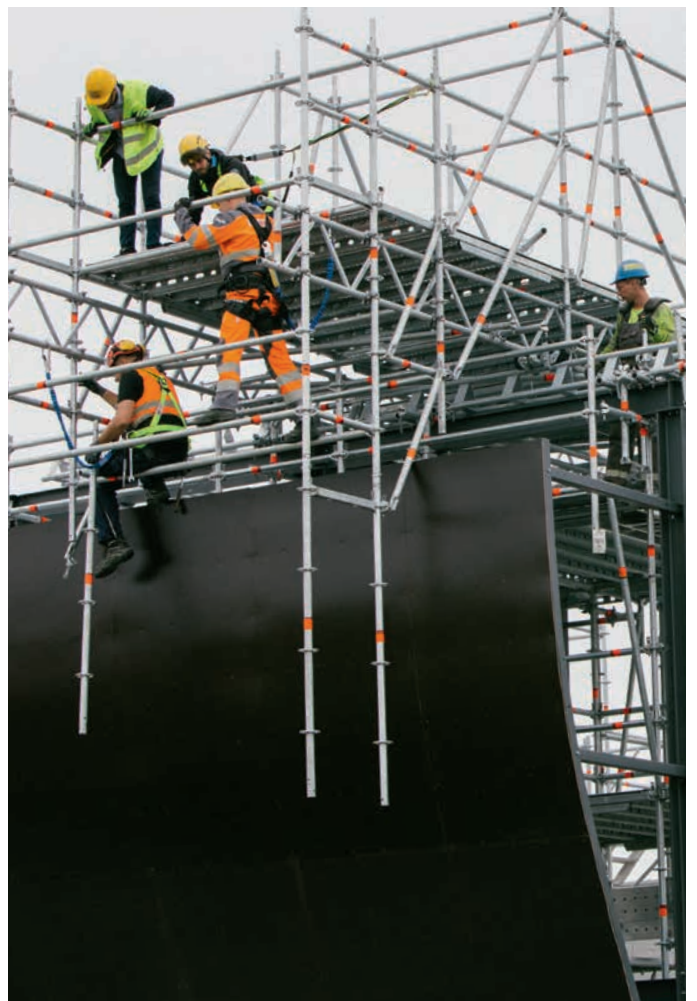
Montage eines auf Schienen fahrbaren Hängegerüsts
