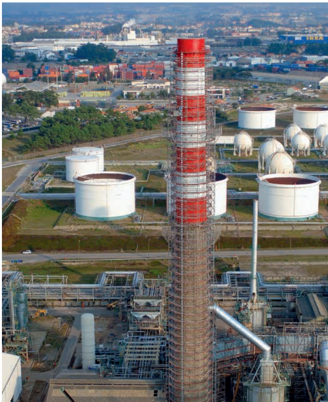
Rundrüstung mit AllroundGerüst an einer Raffinerie-Kolonne
