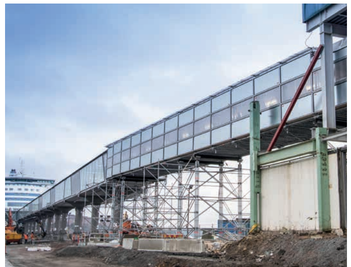
Temporäre Fährterminal-Gangway
