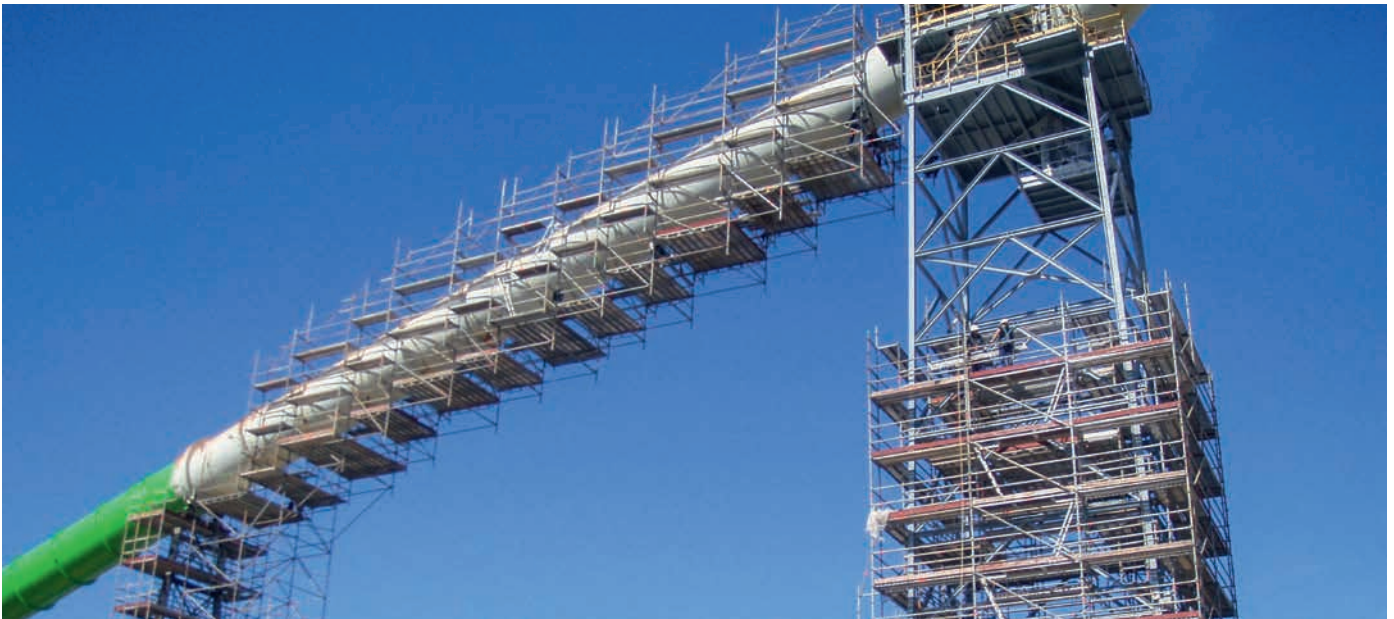
Hängegerüstkonstruktion an Rohrleitung
