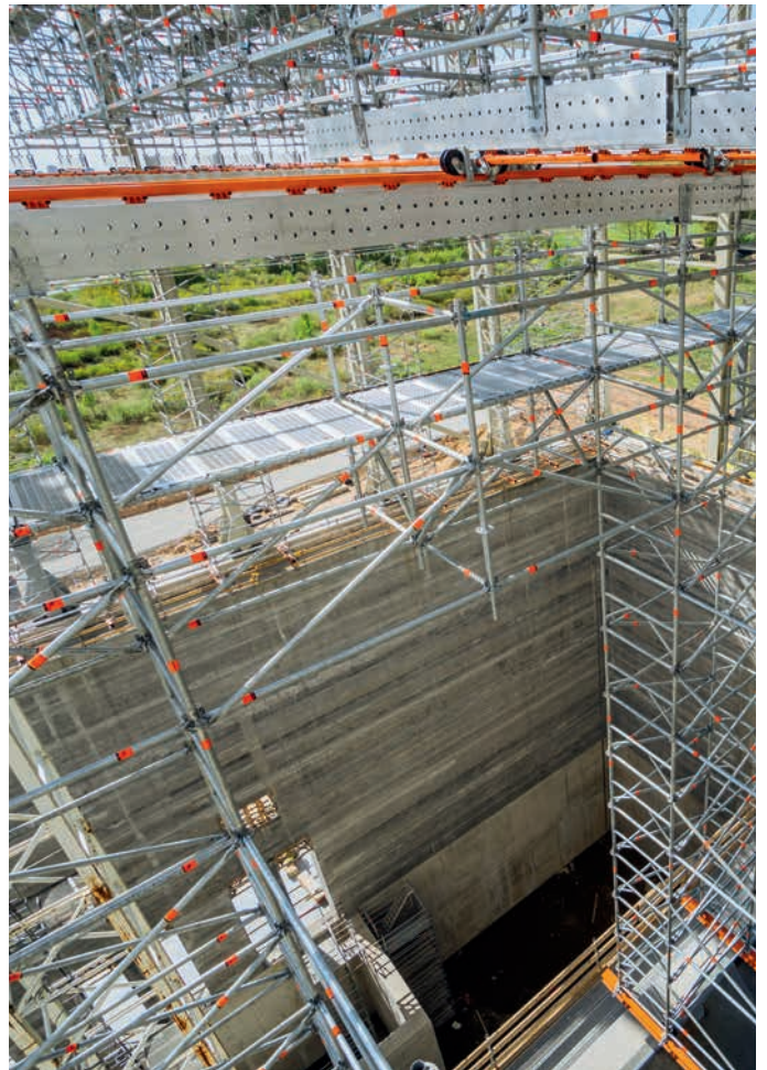
Traggerüst TG 60 in Kombination mit dem Aluminium-Träger FlexBeam und dem Allround Fachwerkträger beim Neubau einer Industrieanlage
