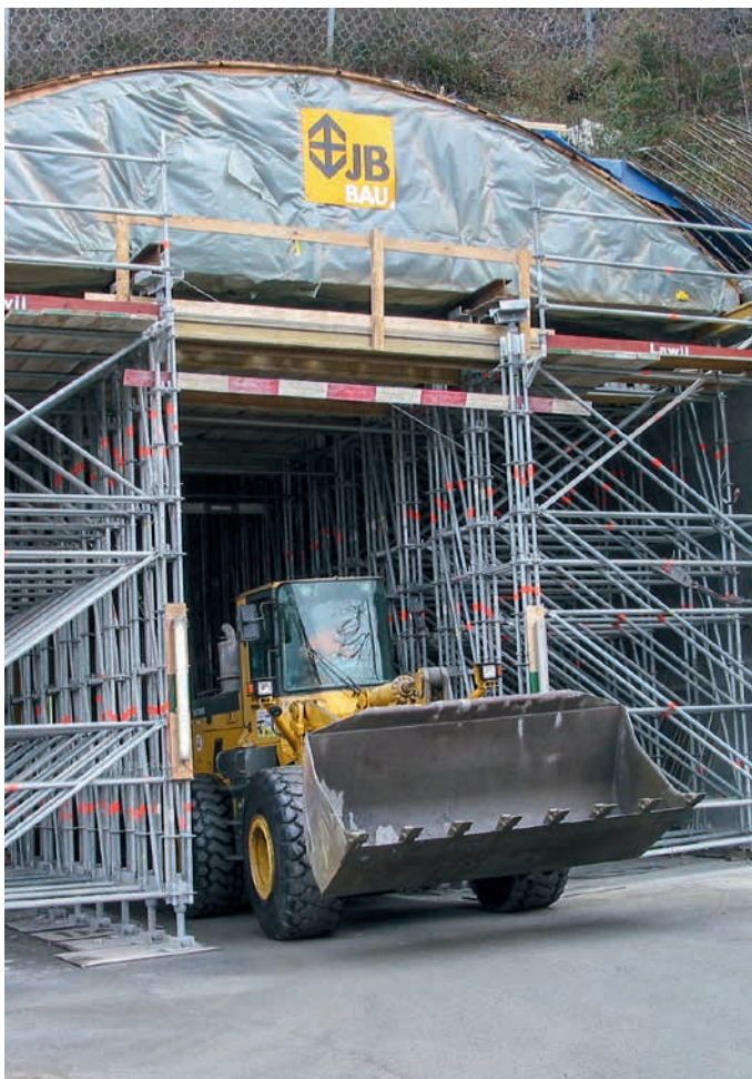
Traggerüst aus AllroundGerüst mit gebündelten Stielen und Durchfahrtsloch für Fahrzeuge
