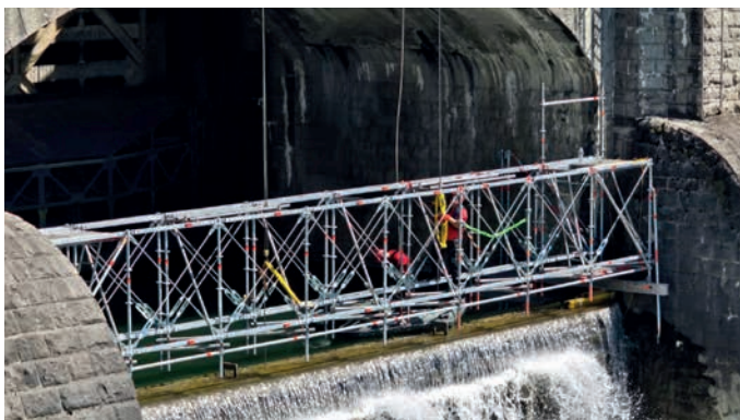
Überbrückung an einem Pumpspeicherkraftwerk aus Allround Fachwerkträgern, aufgelagert auf Aluminium-Trägern TwixBeam
