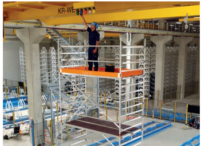
Uni Breit P2 bei Wartungsarbeiten an einem Industriehallenkran
