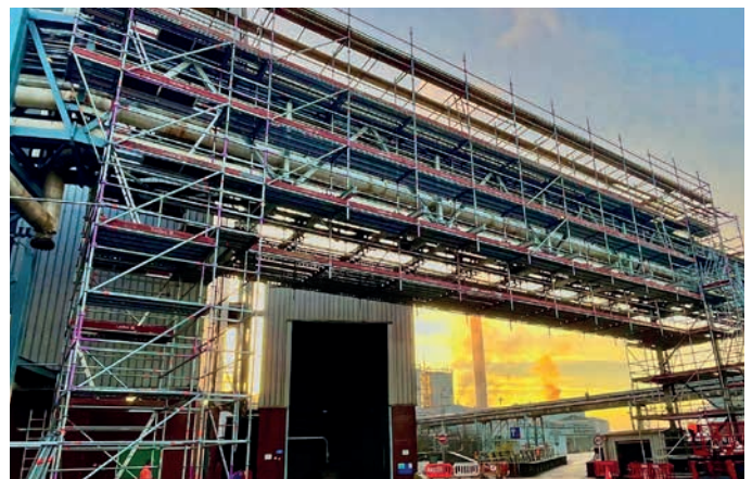
Eingerüstete Rohrleitungen, abgehängt am Aluminium-Träger TwixBeam
