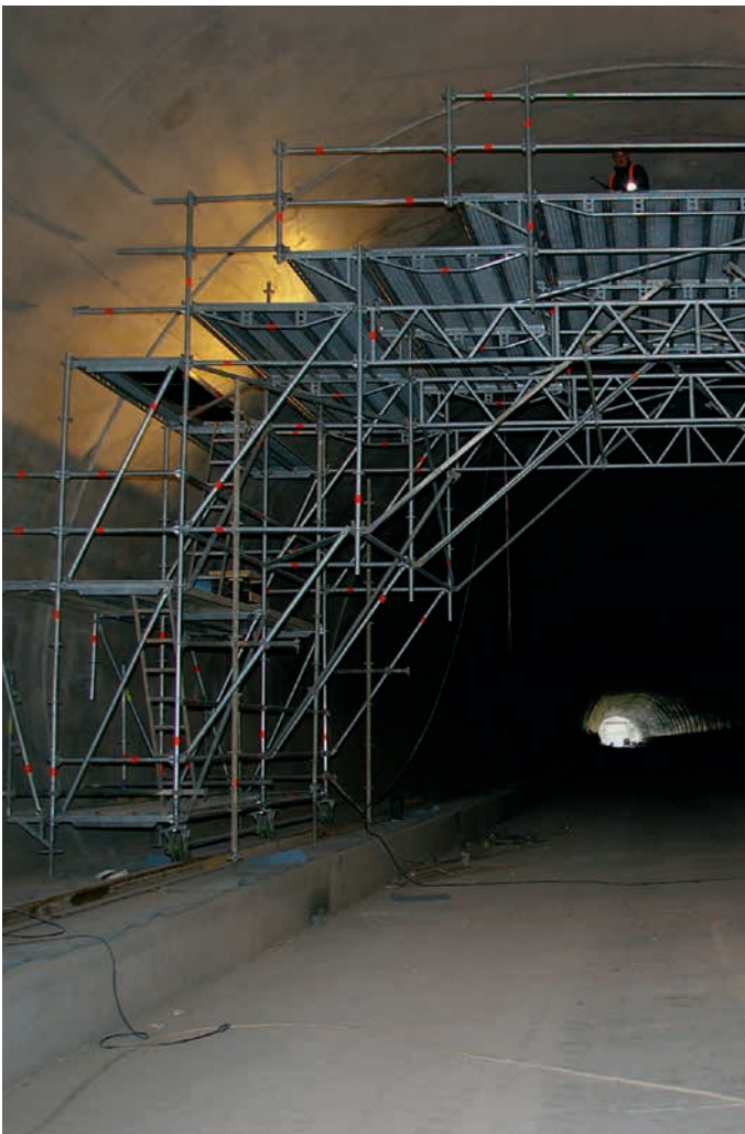
Fahrbares Arbeitsgerüst aus AllroundGerüst für Wand- und Deckenarbeiten
