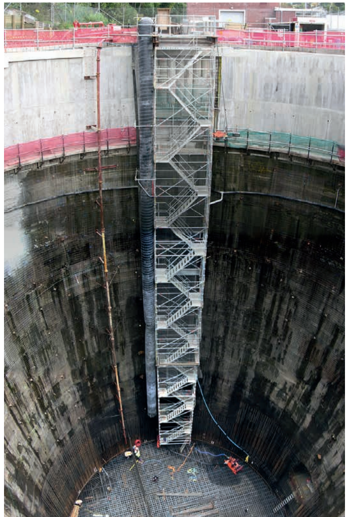
Hängend ausgeführter, gegenlaufender Podesttreppenturm
