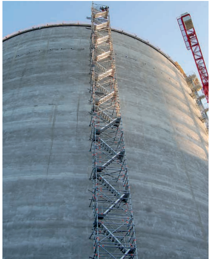
Gegenlaufender Allround Modultreppenturm an einem Silo
