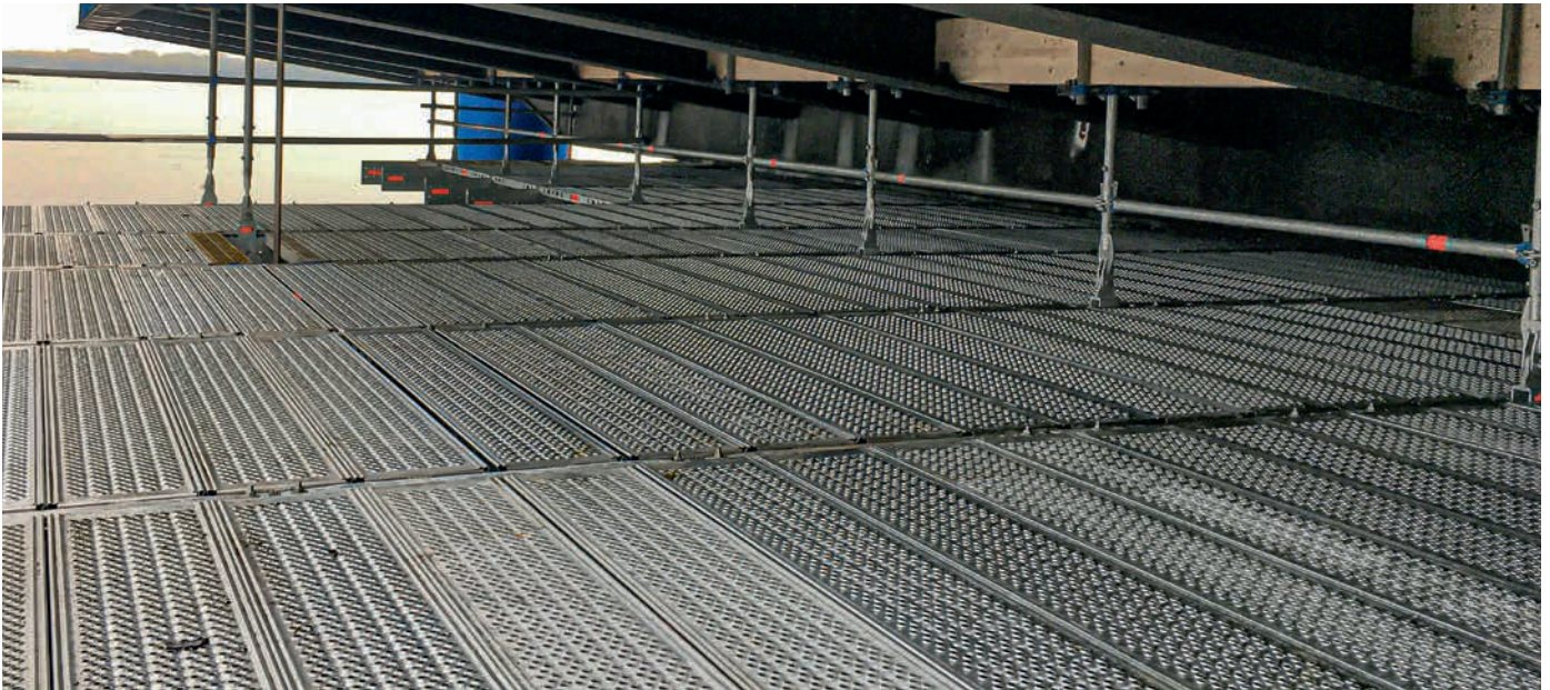
Stolperfreie und vollständig geschlossene Ausdeckung mit Serien-Stahlböden
