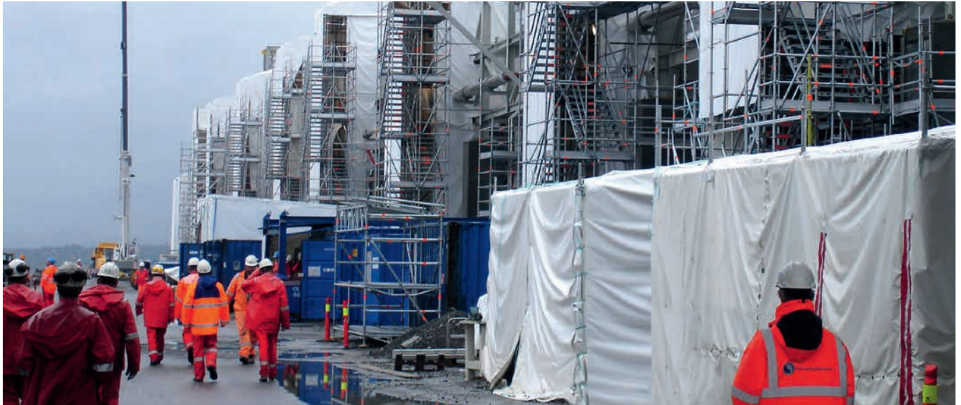
Treppentürme als effizienter Zugang zum Arbeitsplatz
