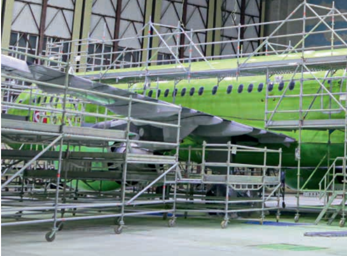
Überbrückung mit Allround Serienteilen
