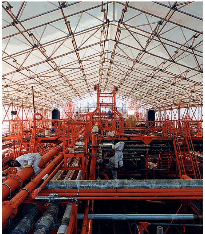
Kederdach bei der Wartung eines Öl-Tankers
