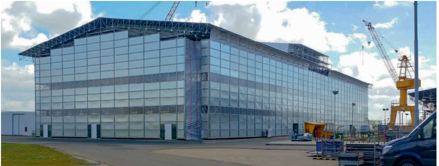
Temporäre Halle mit Kassettendach und Protect-System
