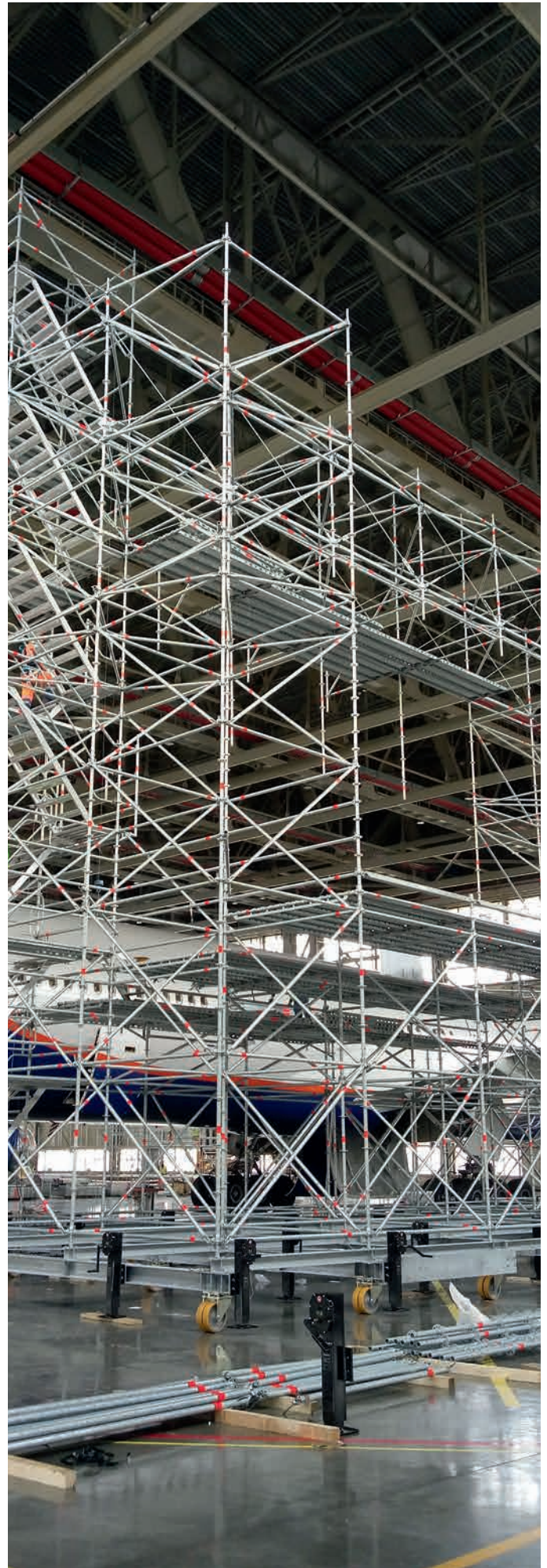
Fachwerkträger-Überbrückung an einem Flugzeugwartungsdock einer Boeing 777
