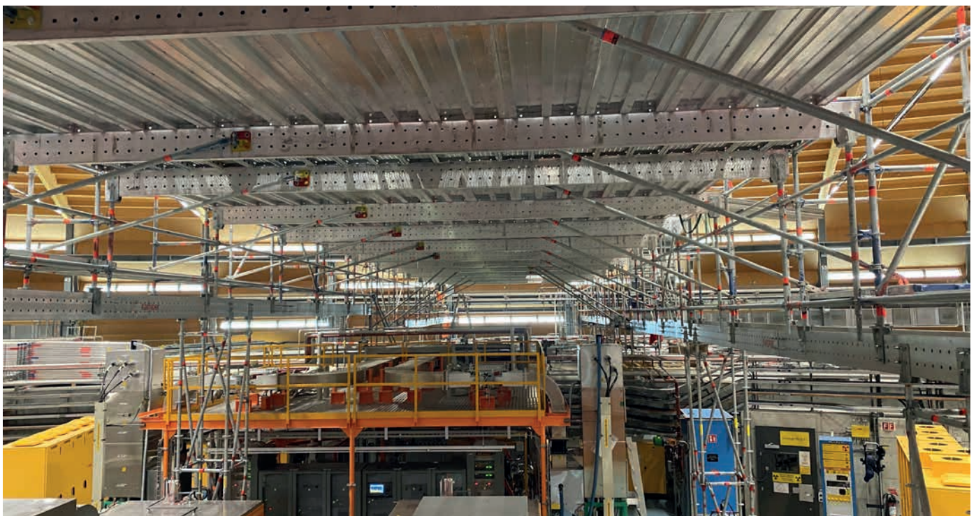
Weit gespanntes Deckenarbeitsgerüst in einer Industriehalle bei laufendem Weiterbetrieb der Anlagen
