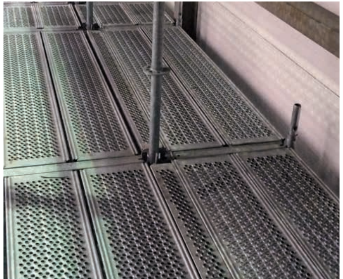
Belagboden mit Keilköpfen zur Schließung des Übergangs zu Konsolflächen
