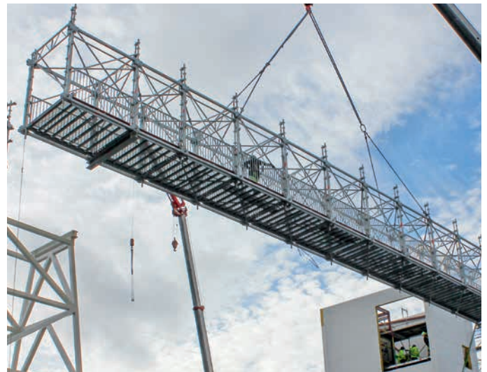
Am Boden vormontierte Fußgängerbrücke mit Allround Brückenträger beim Einkranen
