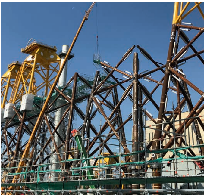
Verkranung einer hängenden Fachwerkträger-Konstruktion
