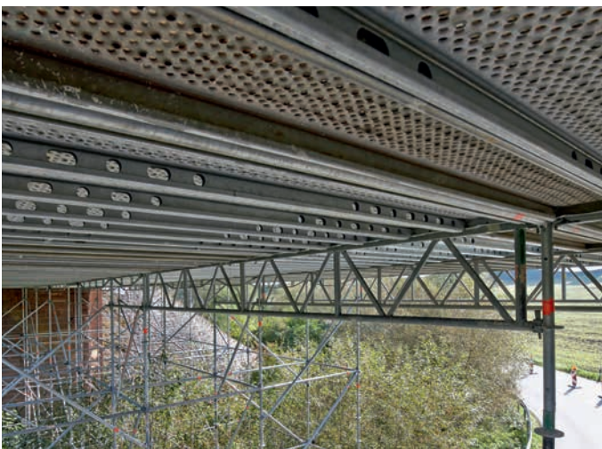
Überbrückung mit Allround Systemgitterträger
