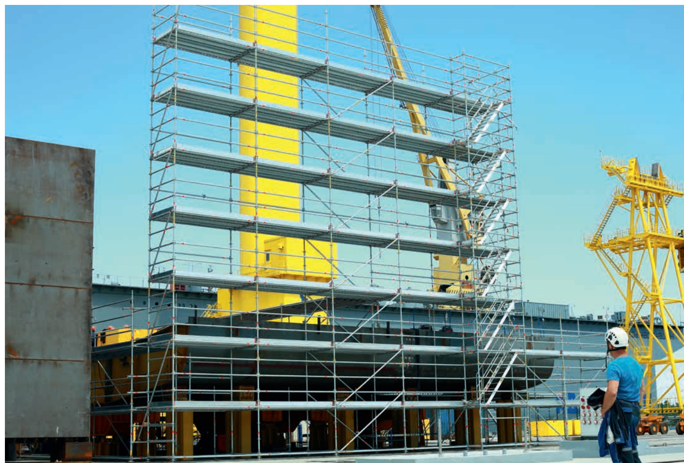
Reduzierung der Brandlast bei einfachen und komplexen Rüstungen mit Stahl-Bordbrettern
