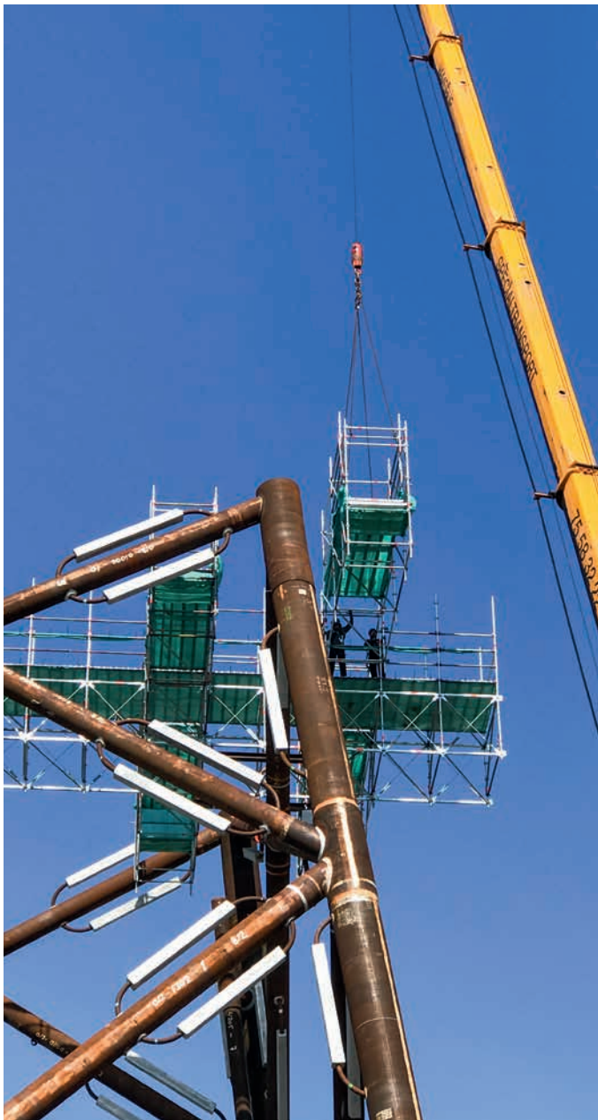
Am Boden vormontiertes freitragendes Hängegerüst mit Allround Fachwerkträger
