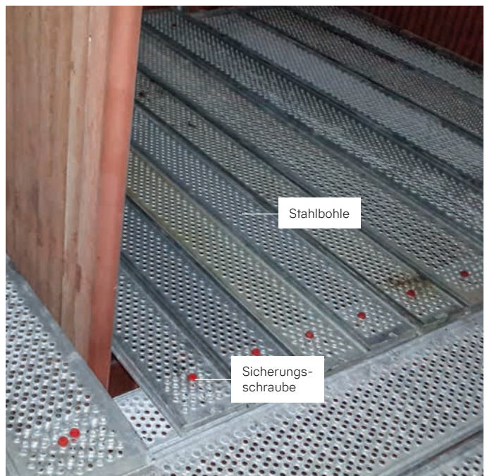
Stahlbohlen, gesichert mit langen Sicherungsschrauben (rot), auf Stahlböden
