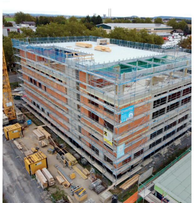
Fassadengerüst mit Fanglage bei Industrie-Neubau
