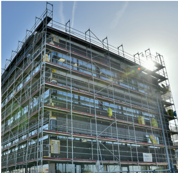
Fassadengerüst an Bürogebäude-Neubau
