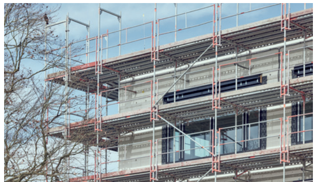
Fassadengerüst mit 1,09 m Breite, Innenkonsolen und I-Geländer
