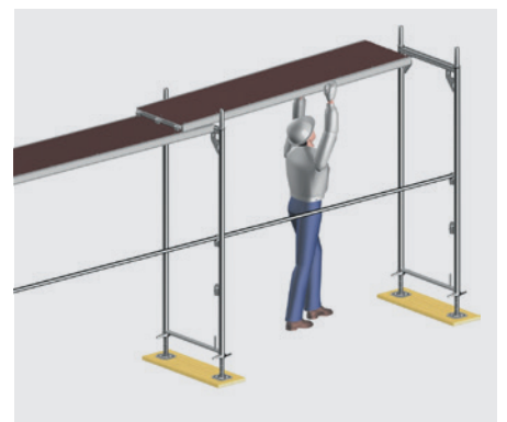
Wirtschaftliche Montage: Layher Gerüstböden gleiten mühelos in das U-Profil.
