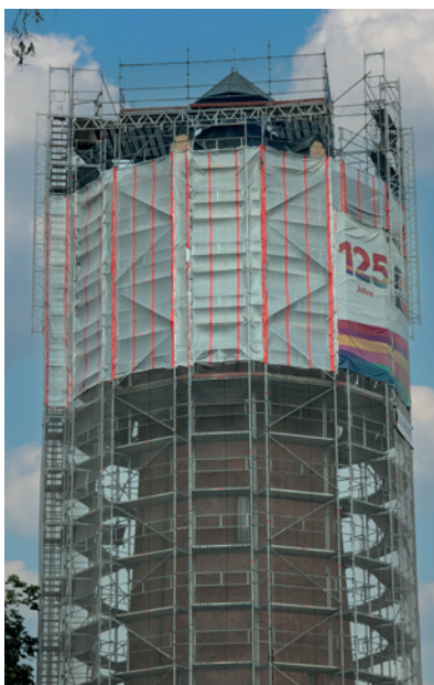
Rundrüstung an einem historischen Wasserturm
